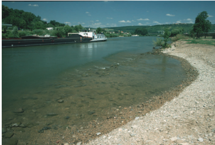
Bild 3: Modellierte steinig kiesige Uferbucht
