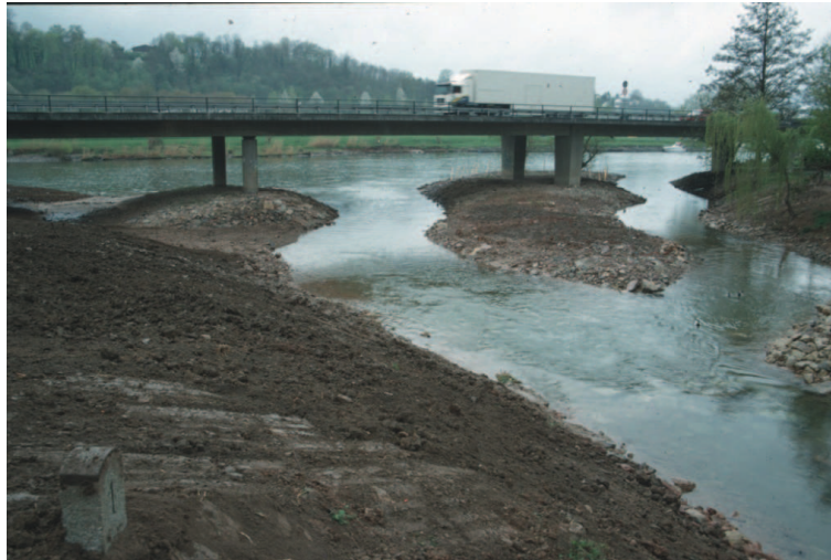
Bild 5: Die Elzmündung nach Umbau 2003
