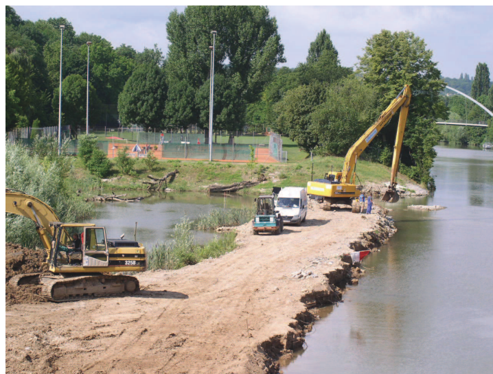
Bild 20: Ausbruch der Neckaruferböschung. Das dahinter liegende Seitengewässer ist bereits gut strukturiert und entwickelt sich rasch.
