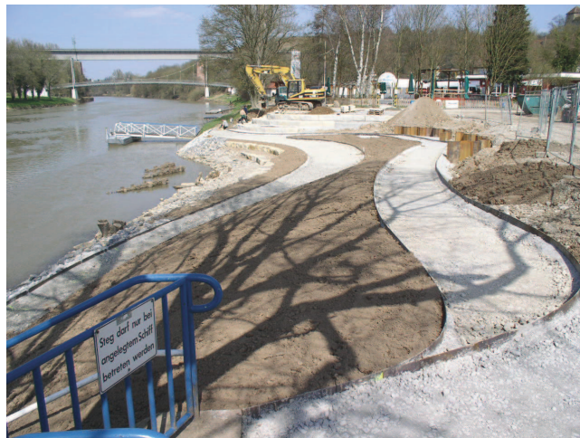
Bild 10: Die neu umgebaute und zugänglich gestaltete Uferbucht mit 3 inklinanten Lahnungsbauwerken Frühjahr 2009.
