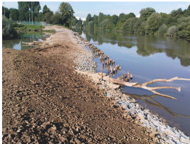
Bild 22: Einbau der Pfahlreihen für die Lahnungsbauwerke im Sommer 2010
