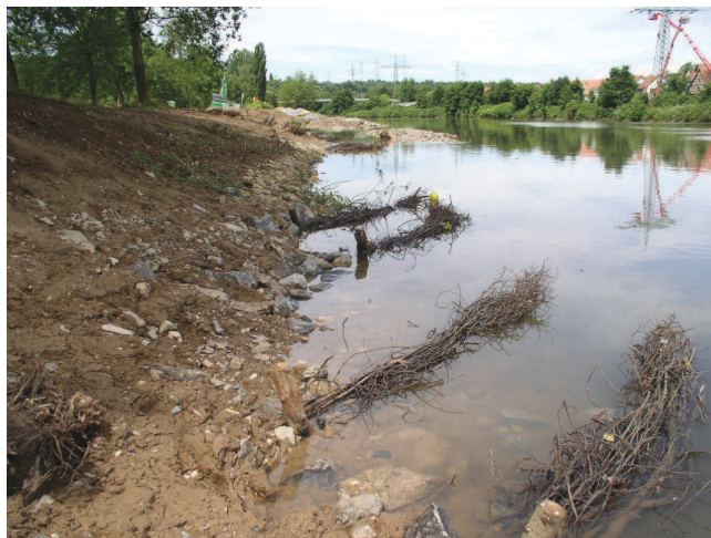
Bild 16: Deklinante Stummelfaschinen zur Habitatbildung am neuen Neckarufer
