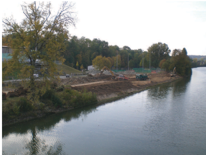
Bild 19: Blick auf die freigelegte Uferböschung, oberstromiger Bereich bereits teilweise abgebrochen
