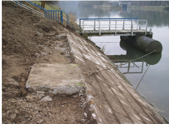
Bild 9: Das freigelegte Ufer bei der Schiffsanlegestelle
