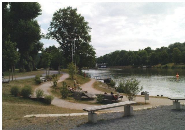
Bild 11: Ein Hochwasser ging kurz nach der Fertigstellung schadlos vorüber. Der Bewuchs entwickelt sich infolge der starken Nutzung im Jahr 2010 lückenhaft.
