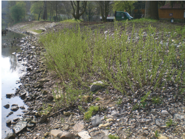
Bild 17: Austrieb einer Weidenspreitlage aus Salix purpurea oberhalb Deckwerk LMB 10/60 aus Steinwurf Neigung 1:3
