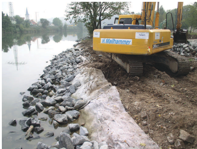
Bild 15: Einbau des neuen Deckwerkes auf Filtervlies, hier bis 100 cm über die Normalstauwasserlage
