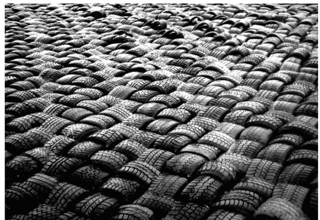
Bild 3.8: Sohlsicherung aus Altreifen
