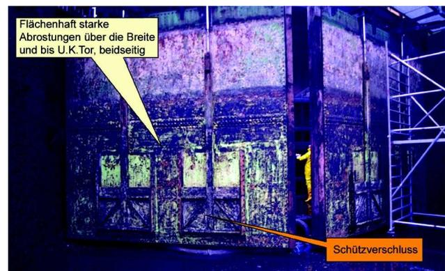
Bild 2.14: Ansicht des trockengelegten Untertores (von OW)
