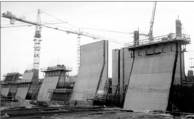
Bild 2.9: Betonage der Kammerwandblöcke der Doppelsparschleuse Hohenwarthe
