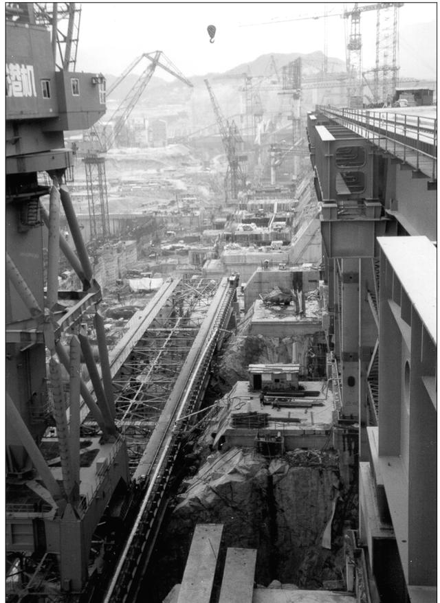
Bild 2.1: Bauzustand des Schiffshebewerkes am Drei-Schluchten-Projekt
