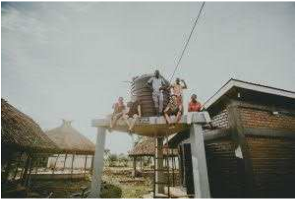
Bild 4: Fertigstellung des dritten Projektabschnittes (Quelle: EWB)
