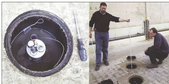
Bild 2.12: Messstellenkopf für artesische Grundwasserhältnisse (links), Messung mittels aufgesetztem Plexiglasrohr (rechts)
