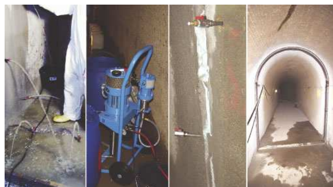
Bild 1.16: Schleuse Erlangen – Verpressarbeiten
