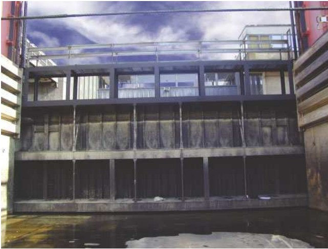
Bild 1.17: Schiffshebewerk Lüneburg – Ansicht Tor
