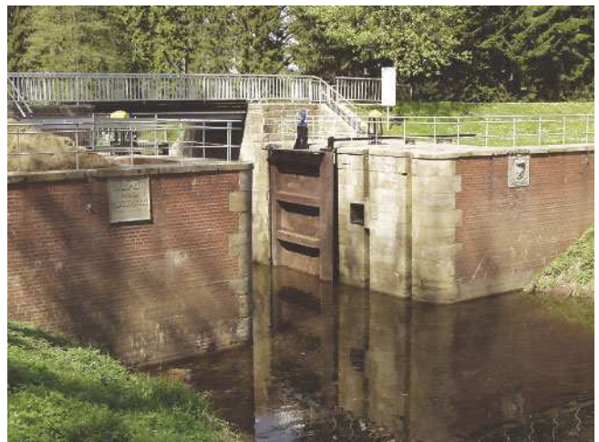
Bild 1.2: Oberhaupt der Schleuse Bentlage
