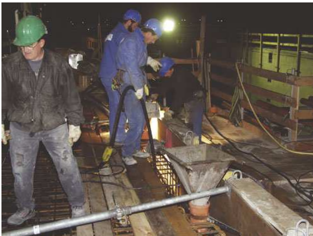
Bild 7.9: Betonage der Vorsatzschale
