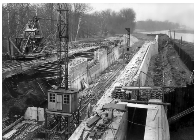
Bild 1.12: Herstellung der landseitigen Schleusenkammerwand der Schleuse Heubach 1930
