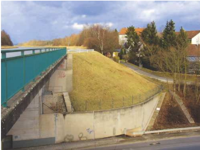
Bild 1.14: Ansicht Kanalbrücke Lohgraben
