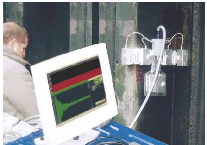
Bild 1.7: Ultraschallwanddickenmessung an der Spundwand der Schleuse Feudenheim
