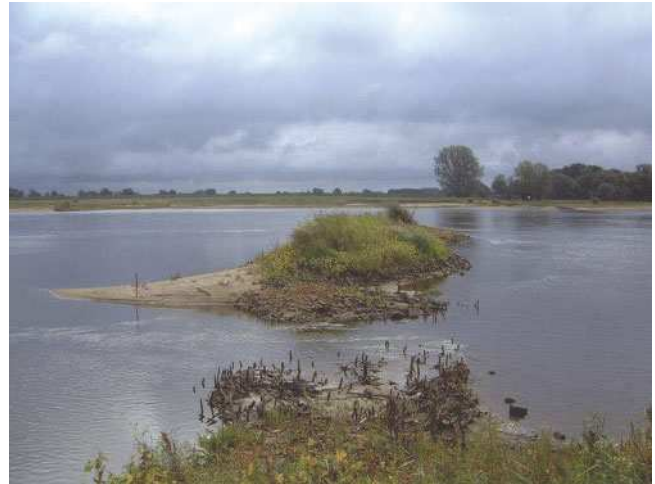
Bild 3.5: Stark zerstörte Buhne in der Pilotstrecke Cumlosen, El-km 467,2, links Aufnahmedatum: 23. September 2003)
