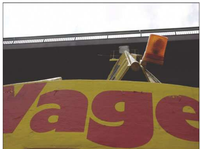
Bild 7.7: Installationsarbeiten an der Kanalbrücke Schwarzach
