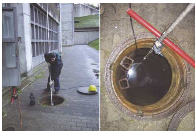
Bild 2.14: Einsetzen der Messsonde in die Dränageschächte
