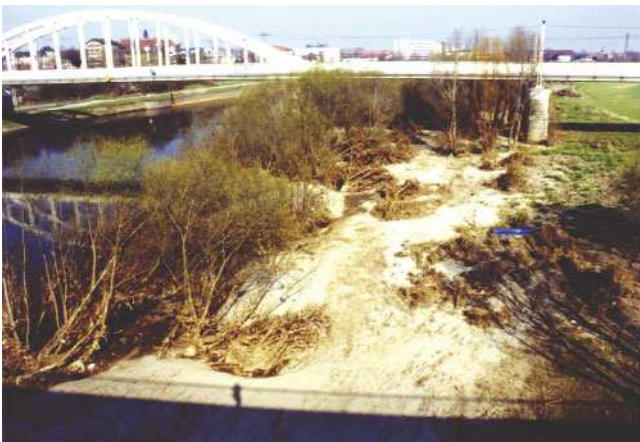
Bild 3.6: Riesa, Blick von der Straßenbrücke nach Unterstrom, Dezember 2002
