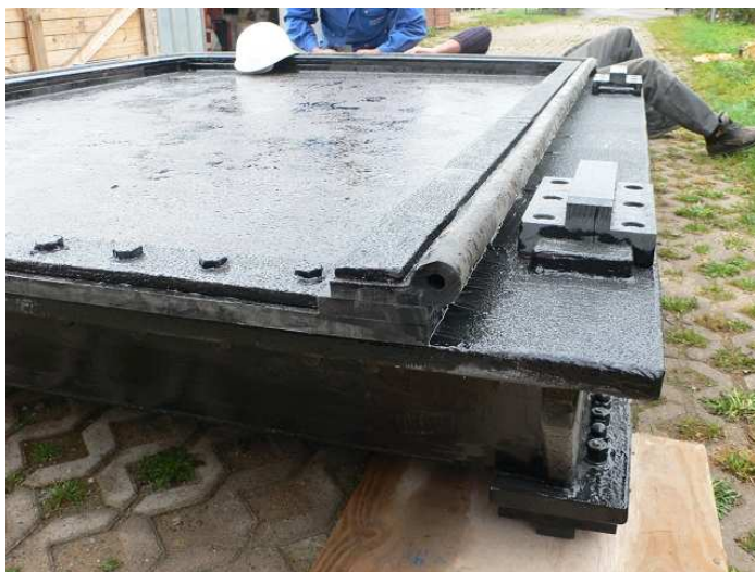
Bild 13: Gleitschütz der Schleuse Hameln
