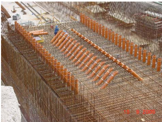
Bild 1: Herstellen der Druckkammerdecke/Schleusenkammersohle der Schleuse Sülfeld mit der bereits eingebauten verlorenen Schalung für die Fülldüsen.
