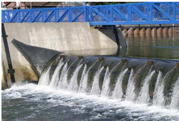
Bild 1: Schlauchwehr Bannetze an der Aller unmittelbar nach der Fertigstellung im Oktober 2009
