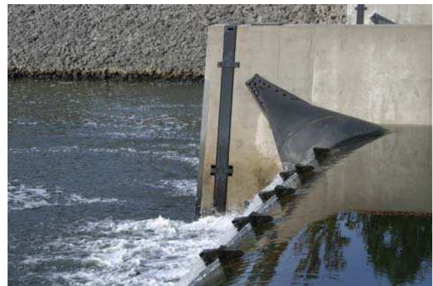
Bild 1: Schlauchwehr Bannetze an der Aller unmittelbar nach der Fertigstellung im Oktober 2009
