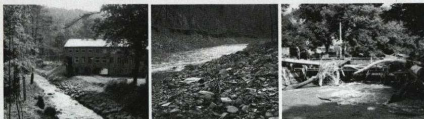
**Abbildung 1** Augusthochwasser 2002: zerstörte Gebäude, Ufererosion, Verklausung von Brücken (Fotos: Bornschein, Hunzinger)
