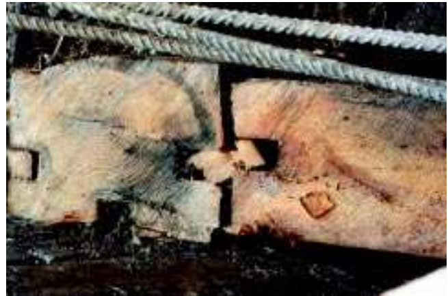
Bild 18: Querschnitt durch eine über 100 Jahre alte Holzspundwand
