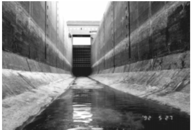
Bild 2: Blick von der trockengelegten Kammer einer Schachtschleuse aus zum Unterhaupt
