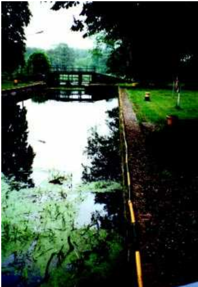
Bild 1: Idyllisch gelegene, alte Schleuse am Finowkanal werken mitunter auftreten, kommen aufgrund des typischen Tragwerkscharakters der Verkehrswasserbauten und dem vorhandenen relativ geringen Schadenspotenzial kaum vor. Nur bei größeren Anlagen entsteht gelegentlich Aufmerksamkeit, wenn z.B. bei einer trockengelegten Schleuse ein Blick von der Kammersohle aus nach oben möglich wird (Bild 2).
