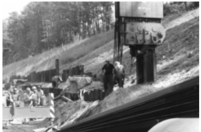
Bild 1: Ziehversuch am Ragöser Damm mit MS 32 HFV
