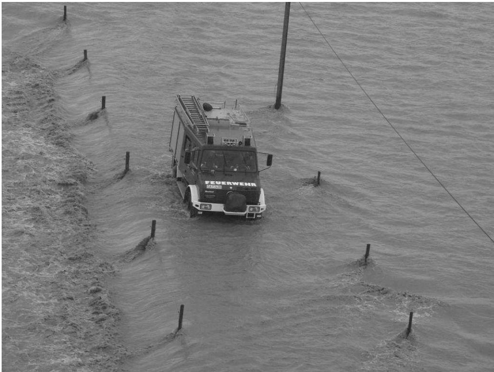
**Abbildung 3:** Überströmter Straßenkörper; deutlich erkennbar ist die Deckwalze am talseitigen Fuß des Straßendamms
