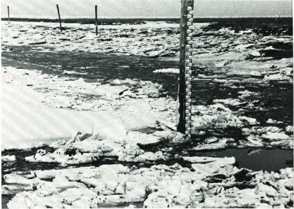
Abb. 2.10. Eisräumung während der Spülung im Hafenbereich – Lattenpegel für Spülsiel-Steuerpegel, Sensor unter der Wasseroberfläche –
