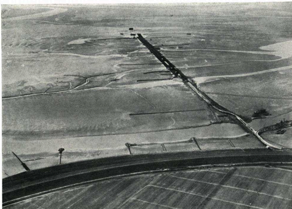
Abb. 3. Der Altfelder Priel (im Vordergrund) bedroht den Seedeich des Friedrichskooges. Der Sicherungsdamm zur Abriegelung des Tiefs ist im Bau (Luftbild 1935, Archiv Marschenbauamt Heide)
