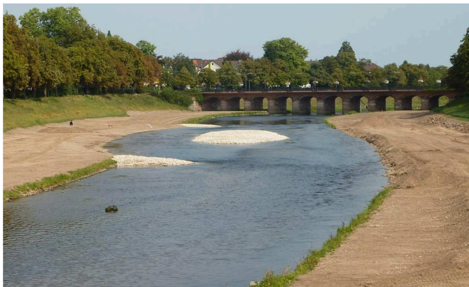
Abbildung 1: Vorlandabtrag mit Strukturverbesserung
