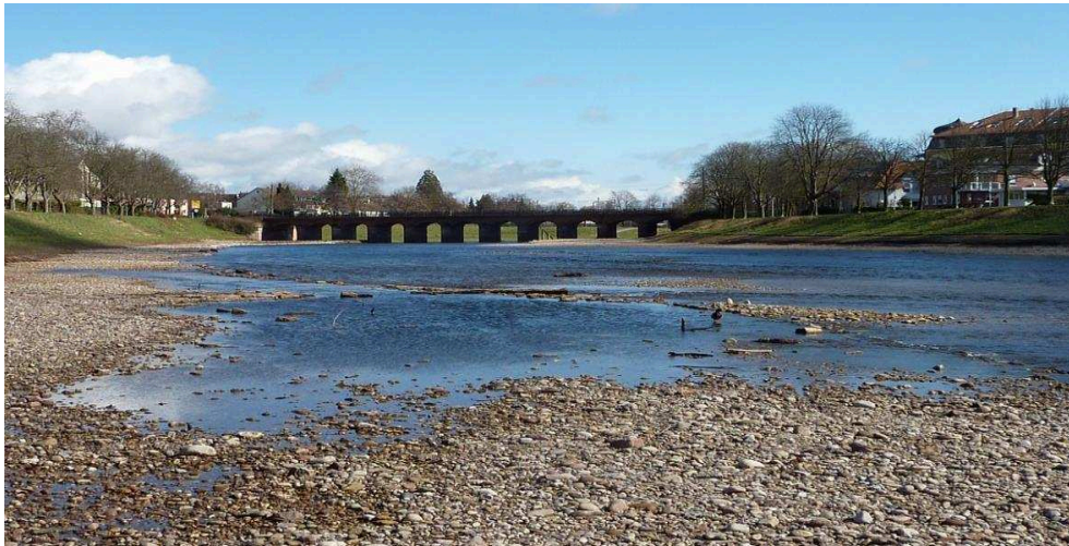
Abbildung 4: Nach dem Hochwasser
