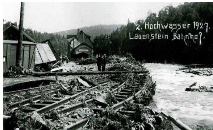
Abbildung 6: Abbildung 1: Bahnhof Lauenstein nach dem Hochwasser 1927
