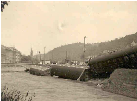
Abbildung 9: Bahnhof Meißen-Triebischtal nach dem Hochwasser 1941 (Foto vom Landratsamt Meißen, Untere Wasserbehörde freundlicherweise zur Verfügung gestellt)
