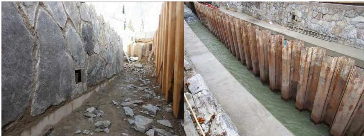
**Abbildung 4:** Fertiggestellte Pflasterung mit glatten Steinen(links), Spundwände (rechts)
