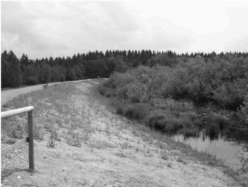
Abbildung 10: Fertig gestellter Dammabschnitt auf gering tragfähigem Untergrund mit Blick in den zukünftigen Stauraum
