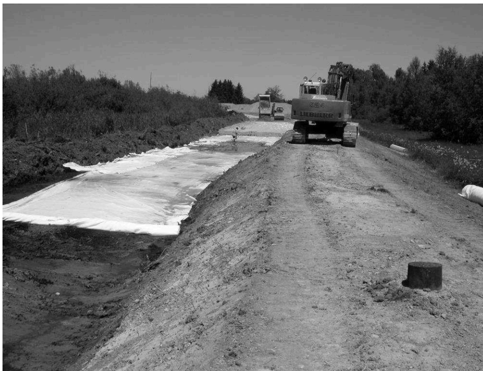
Abbildung 8: Weiterer Baufortschritt im Bereich des gering tragfähigen Baugrunds; der Dammbestand dient zugleich als Baustraße
