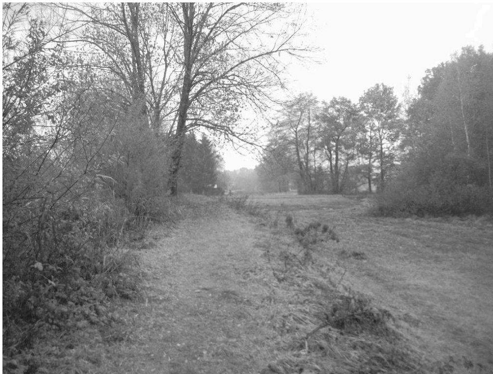
Abbildung 1: Ansicht des Dammkörpers. Stauraumseite links mit Baum- und Strauchbestand. Ab Dammfuß auf der rechten Seite beginnt der Biotopbereich.
