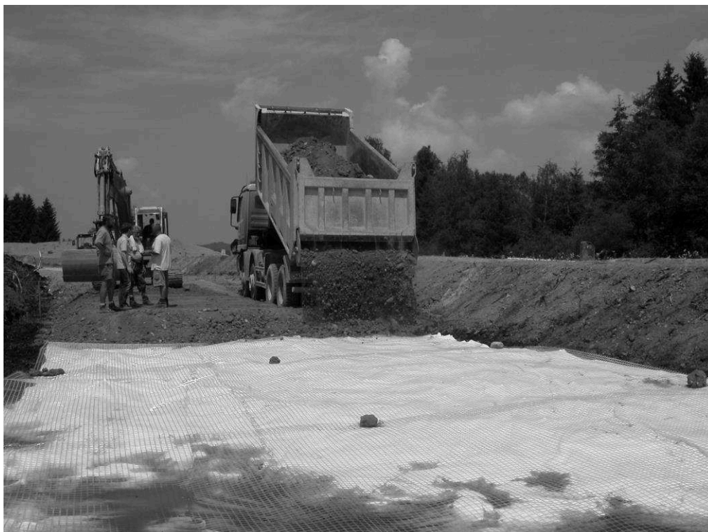
Abbildung 7: Einbau der ersten Schüttlage auf vliesunterlegtem Geogitter
