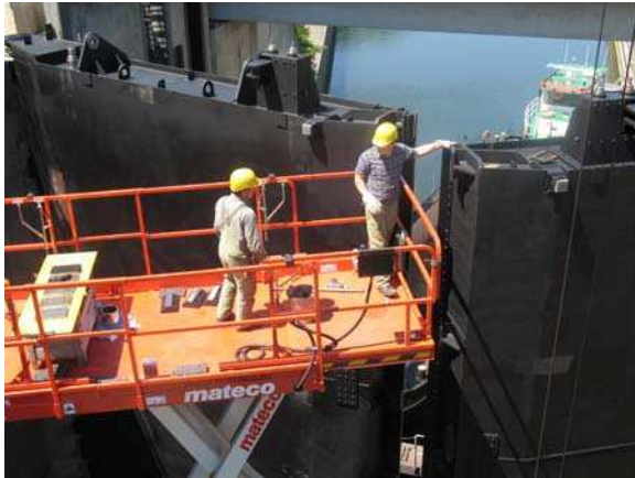
Arbeiten mit der Hubarbeitsbühne an der Schlagsäule
