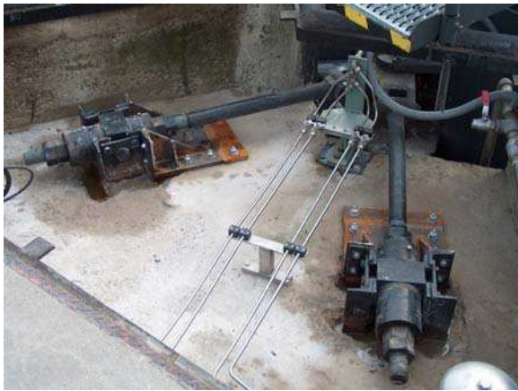
Temporäre Verstärkung mit Konsolen
