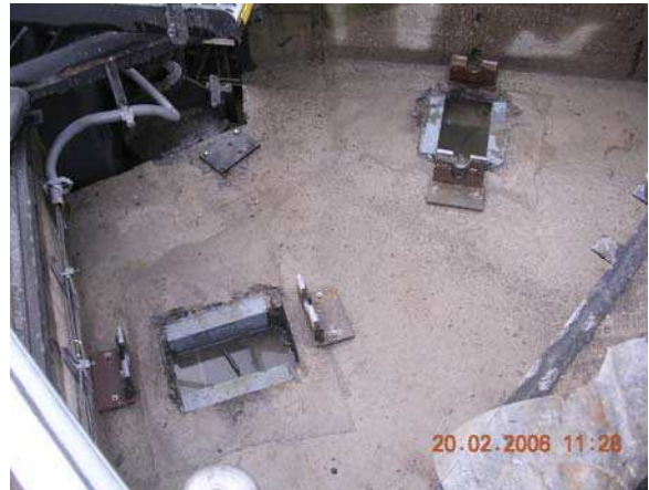
Hilfskonstruktion für Bolzenfixierung
