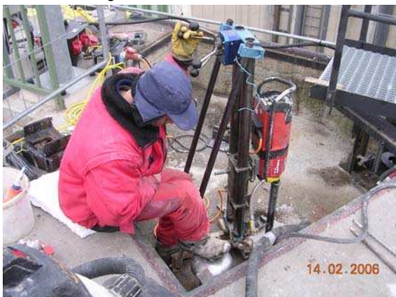
Einbringen der Kernbohrungen
