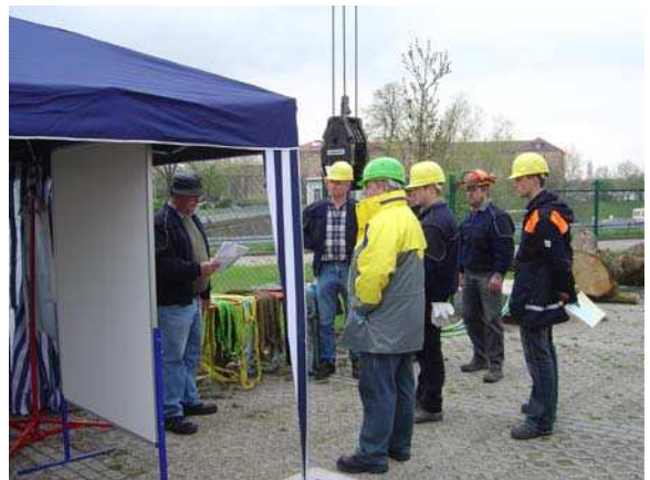
Bild 7 - Arbeiten mit dem Autokran
