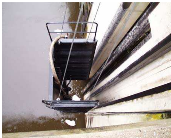
Einbau des Taucherkastens an der Revisionsverschlussschleuse
