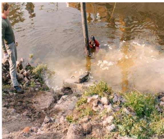
Tauchereinsatz beim Bau der Ultraschallmessanlage Fremersdorf im Jahre 1991
