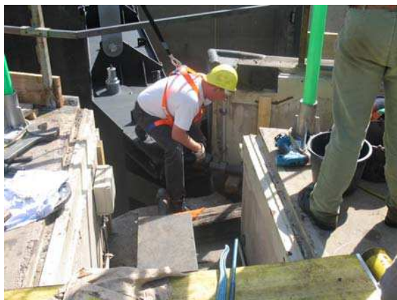
Arbeiten an der Halslager-Verankerung
