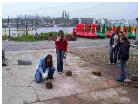
Pflasterarbeiten im ABz Wiesbaden
