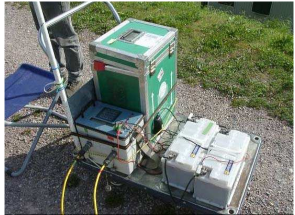
Messapparatur mit Stromversorgung
