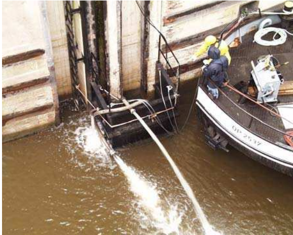
Trockenlegung des Taucherkastens
