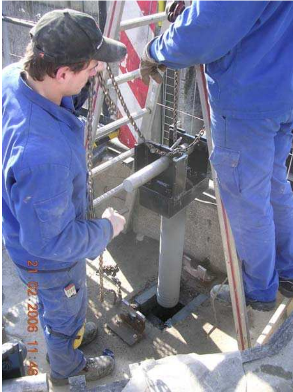
Einlassen der neuen Widerlager
