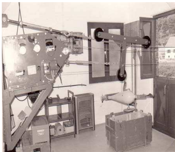
Seilkrananlage Pegel Mettlach (Messraum)
