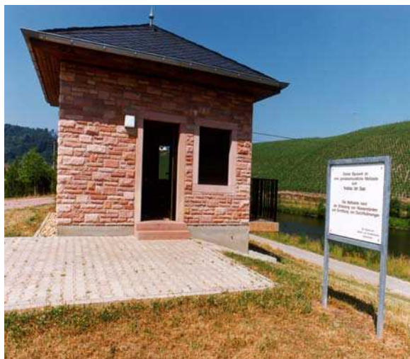
Seilkrananlage Schoden (Vorderansicht)
