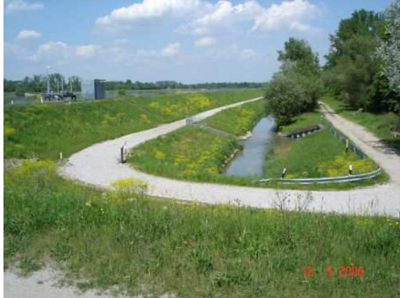
Landseitiger Blick auf den Damm mit Einlassbauwerk
