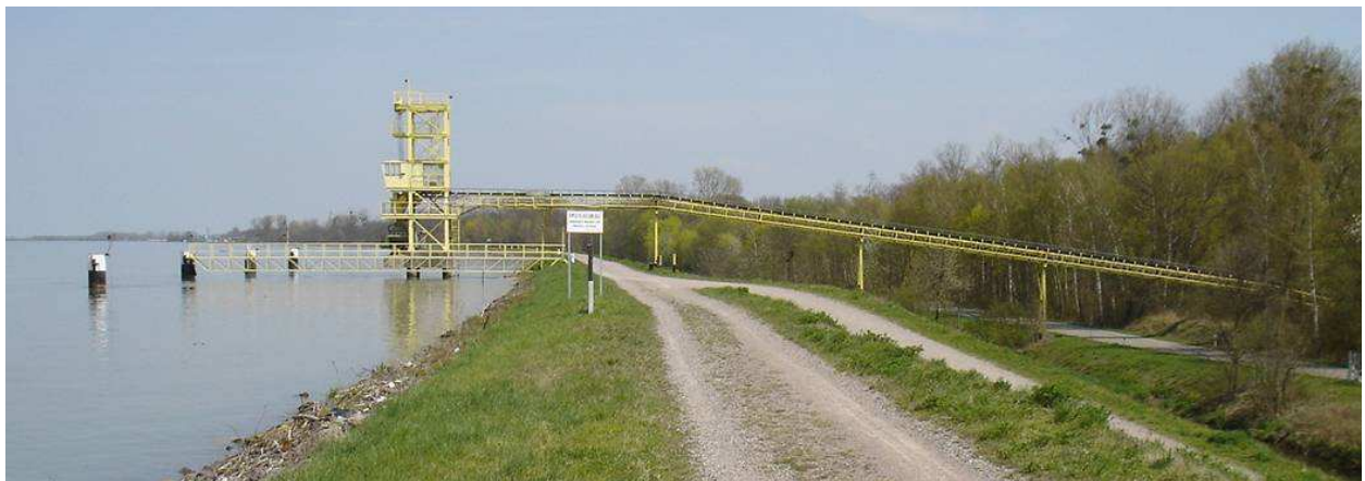
Beispiel für eine Kiesverladeanlage am Oberrhein
