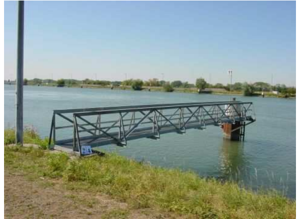
Schiffsanleger mit Dalben im Schleusenvorhafen der Schleuse Iffezheim
