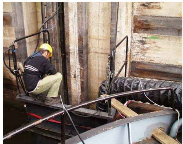
Sicherungsposten bei Arbeiten im Taucherkasten
