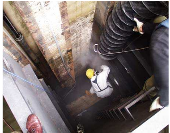
Reparatur der Revisionsverschlussnische bei eingebautem Taucherkasten
