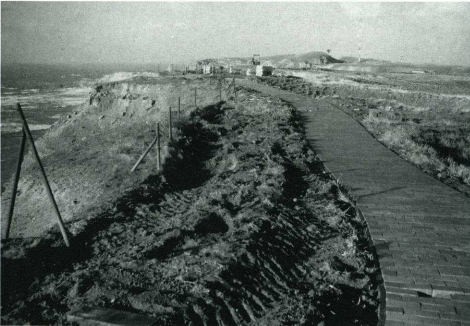
Abb. 15: Klippenrandweg, Bauzustand – Januar 1990 –
