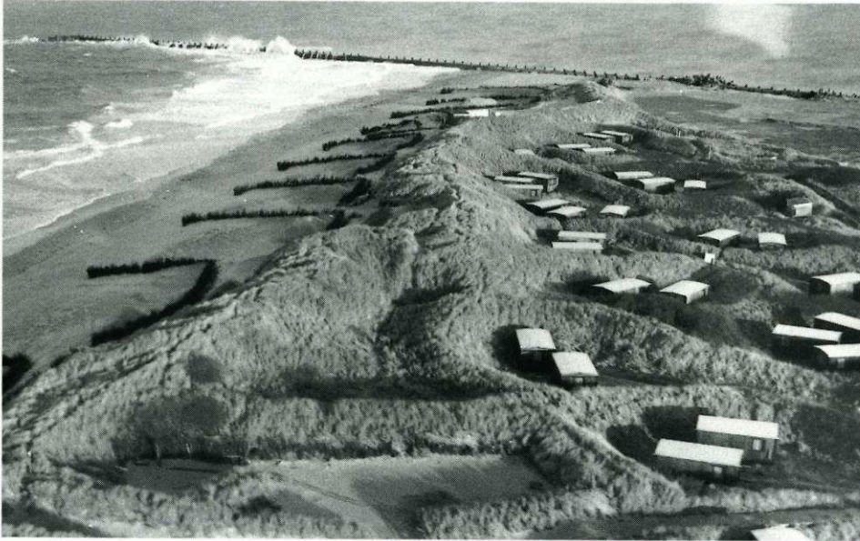
Abb. 25: Nordstrand der Düne mit Sandfangzäunen (Januar 1990, Freigabe Nr. SH 1588/1)
