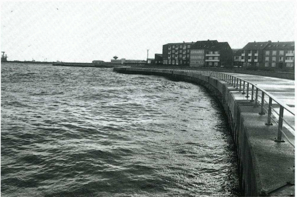
Abb. 10: Das sanierte Promenaden-Bohlwerk nach der Fertigstellung 1987
