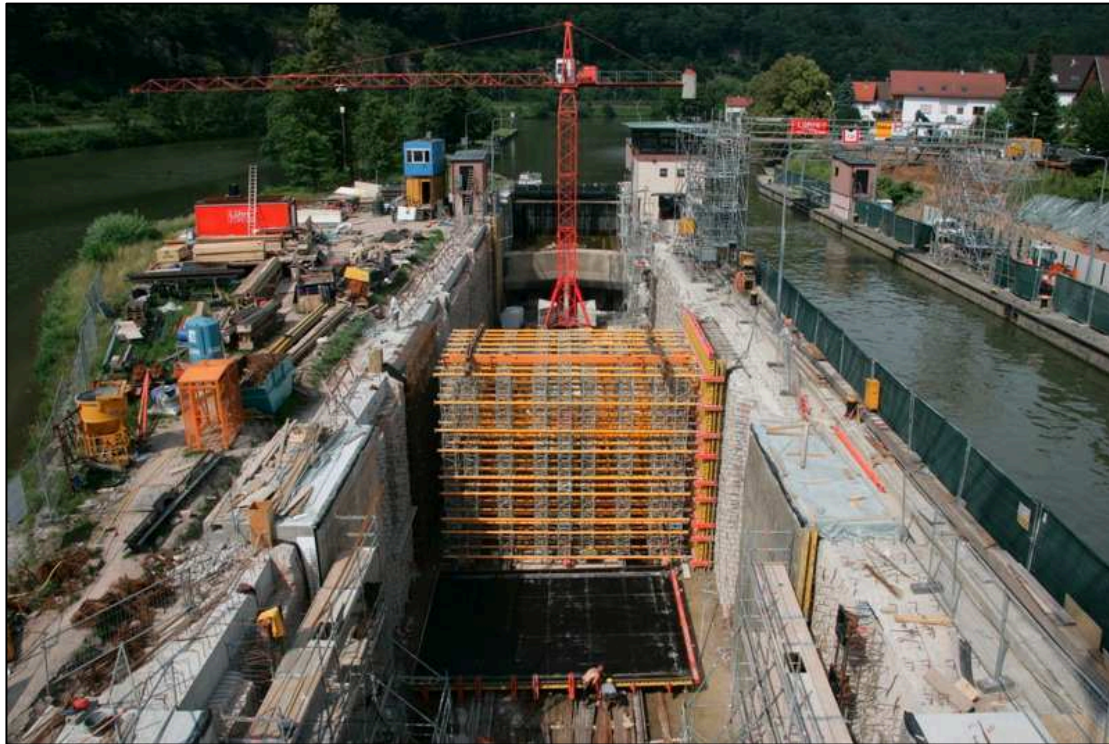
Abbildung 1: Instandsetzung der Schwergewichtswände der Schleuse Hirschhorn im Jahr 2006
