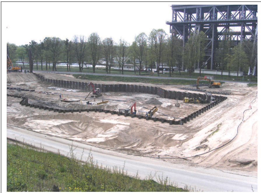
Bild 13: Blick auf die Baugrube für das neue Schiffshebewerk Niederfinow
