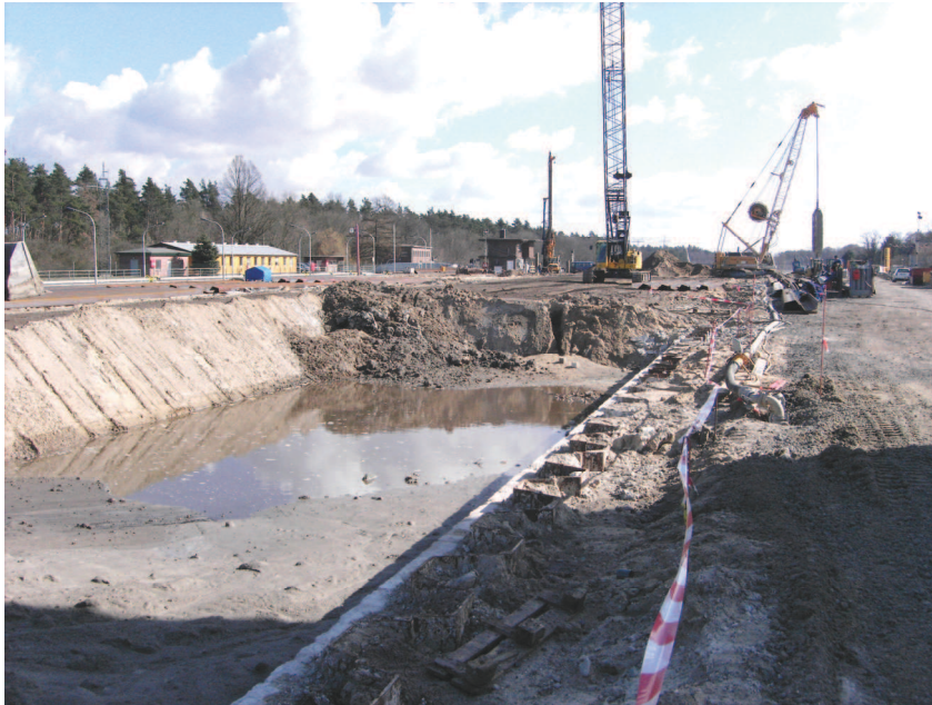
Bild 14: Blick in die Baugrube der Südkammer Schleuse Wusterwitz
