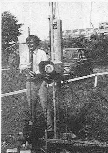
Bild 6. Elektro-automatische Rammsonde für leichte und mittlere Sondie- rungen aus der BRD
