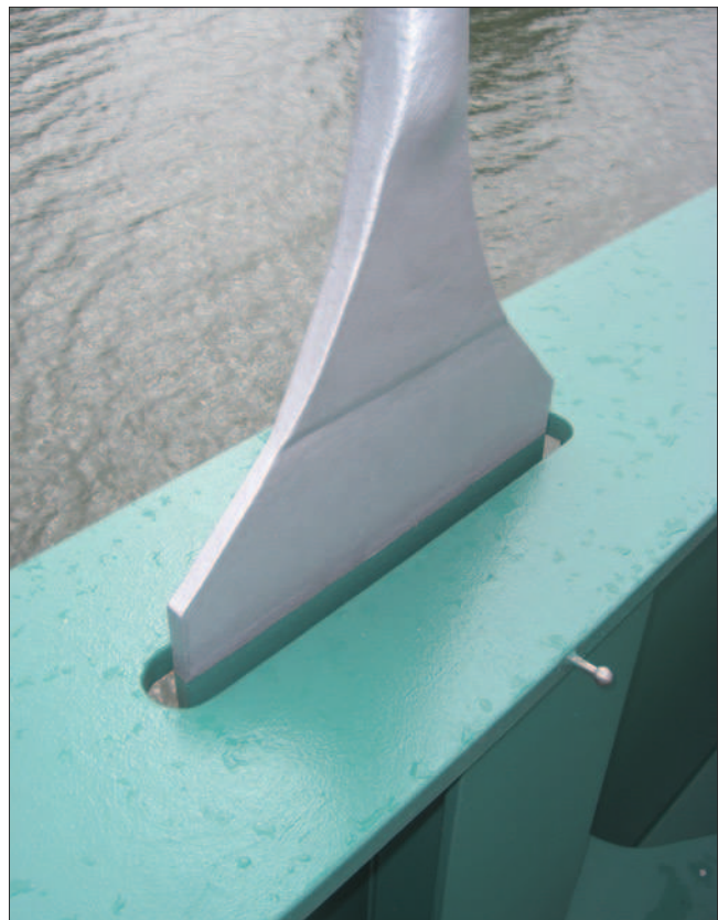
Bild 1: Geschmiedeter Hängeranschluss
