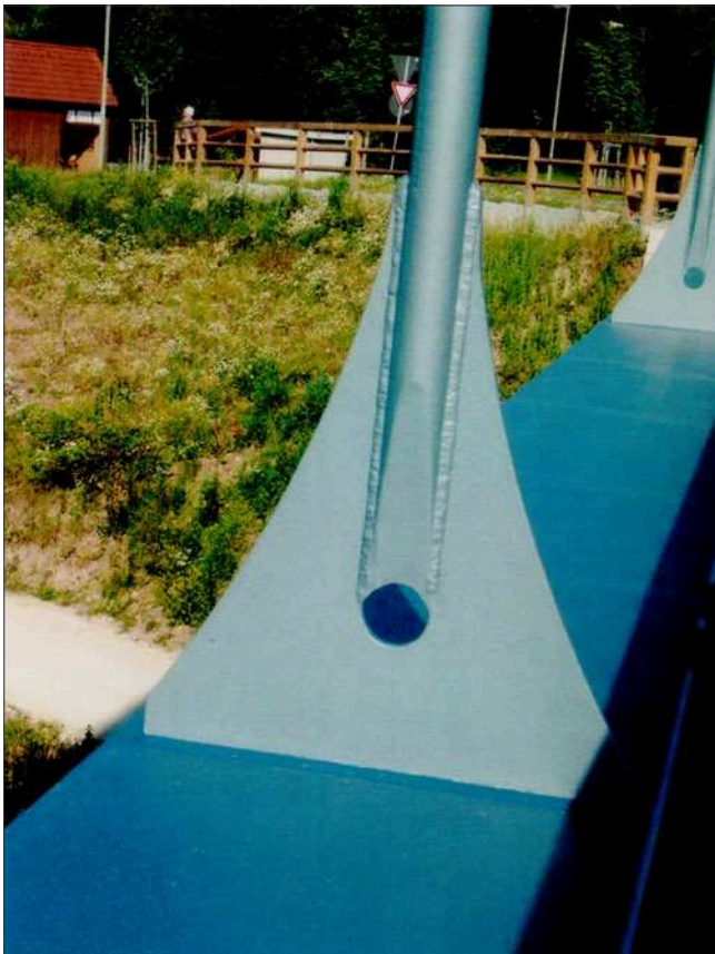
Bild 1: Hängeranschlusskonstruktion, bemessen nach neuem Regelwerk
