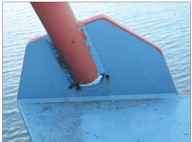
Bild 2: Anschlusskonstruktion aus dem Baujahr 1997
