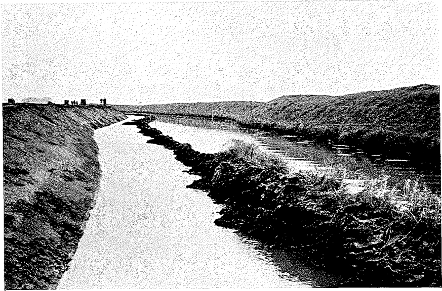
Aufn. Marschenbauamt Heide 1938 Abb. 21. Verbreiterung der Broklandsau.
