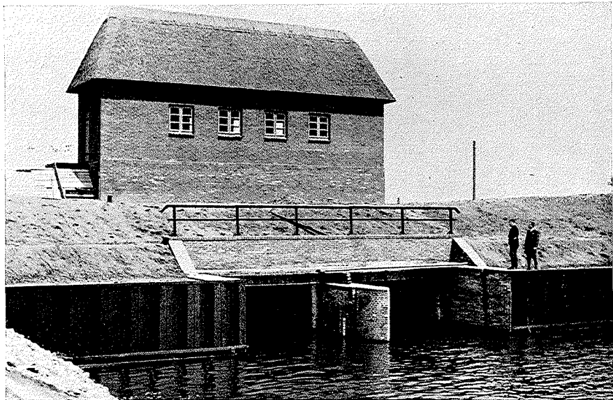
Aufn. Marschenbauamt Heide 1938 Abb. 26. Die Steinschleuse (Sorge) nach Fertigstellung. Ansicht von unterhalb.
