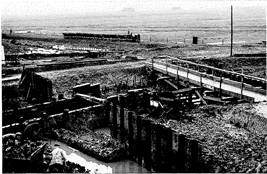
Aufn. Marschenbauamt Heide 1938 Abb. 22. Abbruch der Broklandsautalschleuse.
