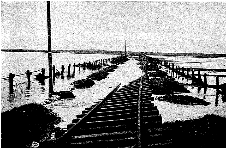
Aufn. Marschenbauamt Heide, Okt. 1928 Abb. 4. Zerstörung der Reichsbahnstrecke Rendsburg-Husum bei Christiansholm durch Überflutung.
