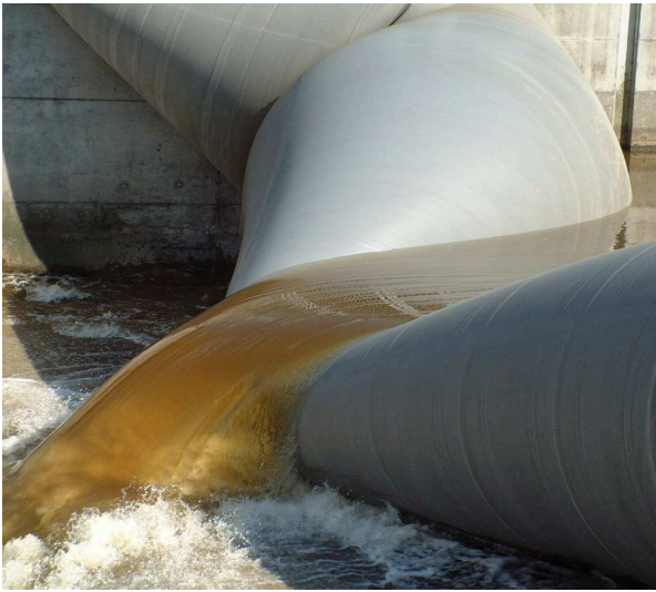
a. Einknicken bei Luftfüllung
