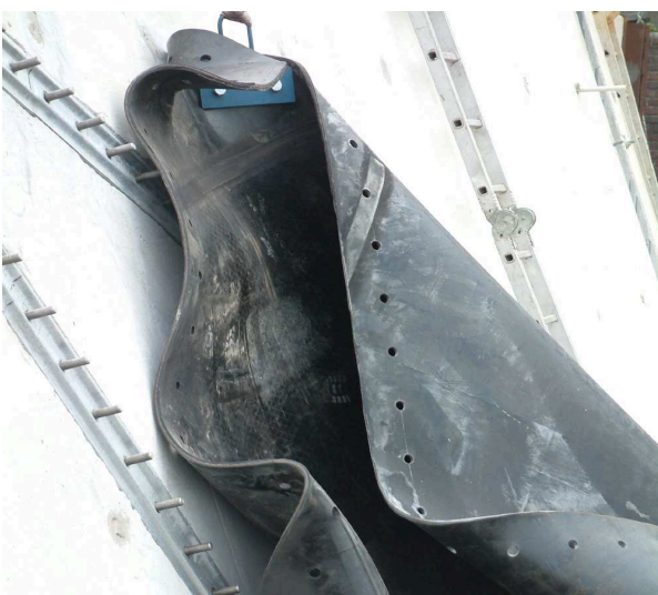
c. bis e. Montage der Schlauchmembran im Oktober 2005
