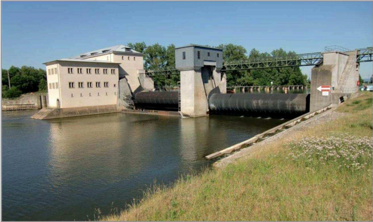
Bild 2: Das Wehr Viereth – Istzustand
