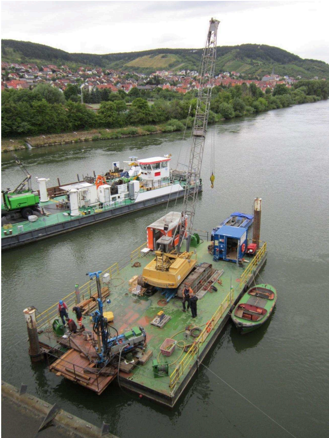
Bild 5: Baugrundbohrungen an der Wehranlage Erlabrunn
