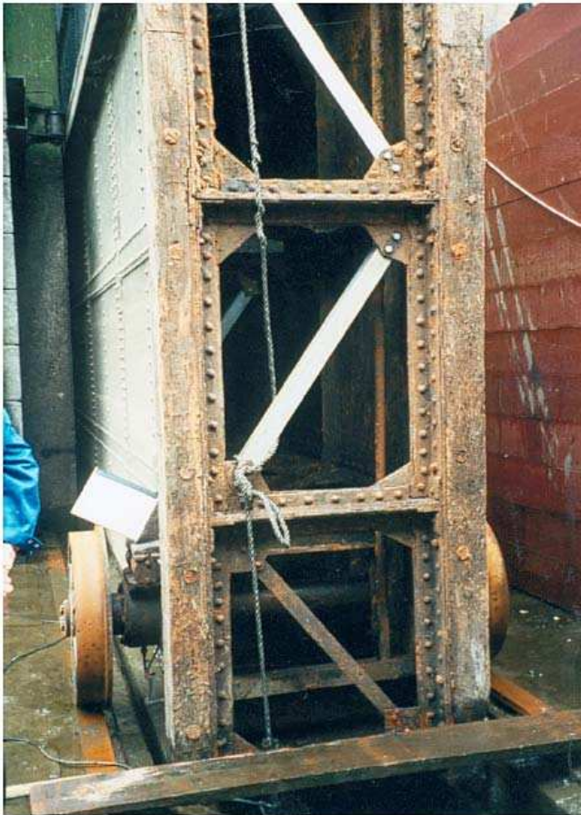
Bild 3. Beispiel für Instandsetzungen an einem Schiebetor
