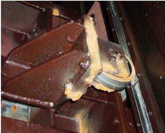
Bild 5. Schäden an einer Laufrolle und deren Halterung infolge elektrochemischer Korrosion
