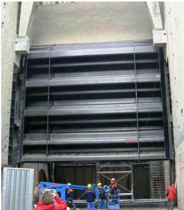
Bild 2. Beispiel für Schleusentor in Faltwerkbauweise
