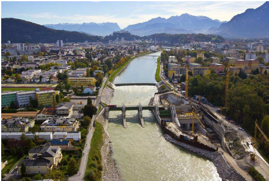
Bild 2: Errichtung Kraftwerk Sohlstufe Lehen Bauphase 2.
