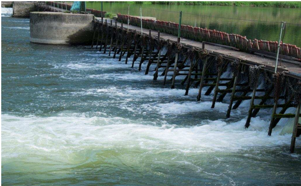
Bild 1: Nadelwehr an der Maas.
