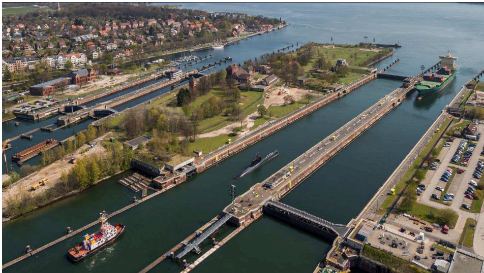
Bild 1: Schleusenanlage Kiel-Holtenau, Von v.r. Große Schleuse, Kleine Schleuse, Auslasskanal mit Auslassbauwerk. (Quelle: Luftbildservice Bernot)
