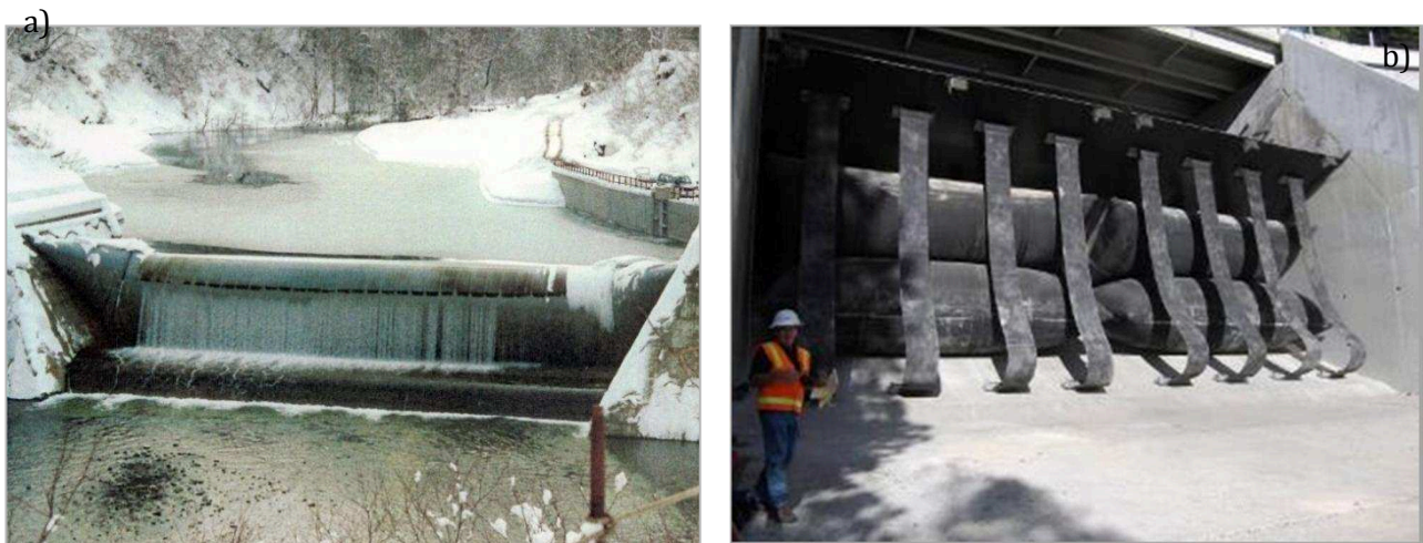
Bild 5: Wehranlagen mit den größten Verschlusshöhen: a) Kurotani Dam, Japan (mit freundlicher Genehmigung von Marsima Aqua system); b) Guiyang, China (mit freundlicher Genehmigung von Dyrhoff Ltd.).
