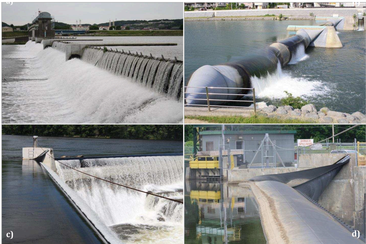
Bild 3: Anwendungsbeispiele für Schlauchwehre und kombinierte Schlauch- und Klappenwehre (Inbetriebnahme, Anzahl Wehrfelder, Verschlussbreite- und -höhe: a) Nikaryo-Kamikawara dam, Tama River, Japan (2012, 5/46,2 m/1,6 m); b) Kamo weir, Ina River, Japan (2001, 2/29,5 m/2,8 m); c) Curtis Dam, Hudson River, USA (2003, 4/20,4-74,6 m/1,2-2,1 m) und d) Highgate Falls, Missisquoi River, USA (1994, 1/67,0 m/4,6 m).
