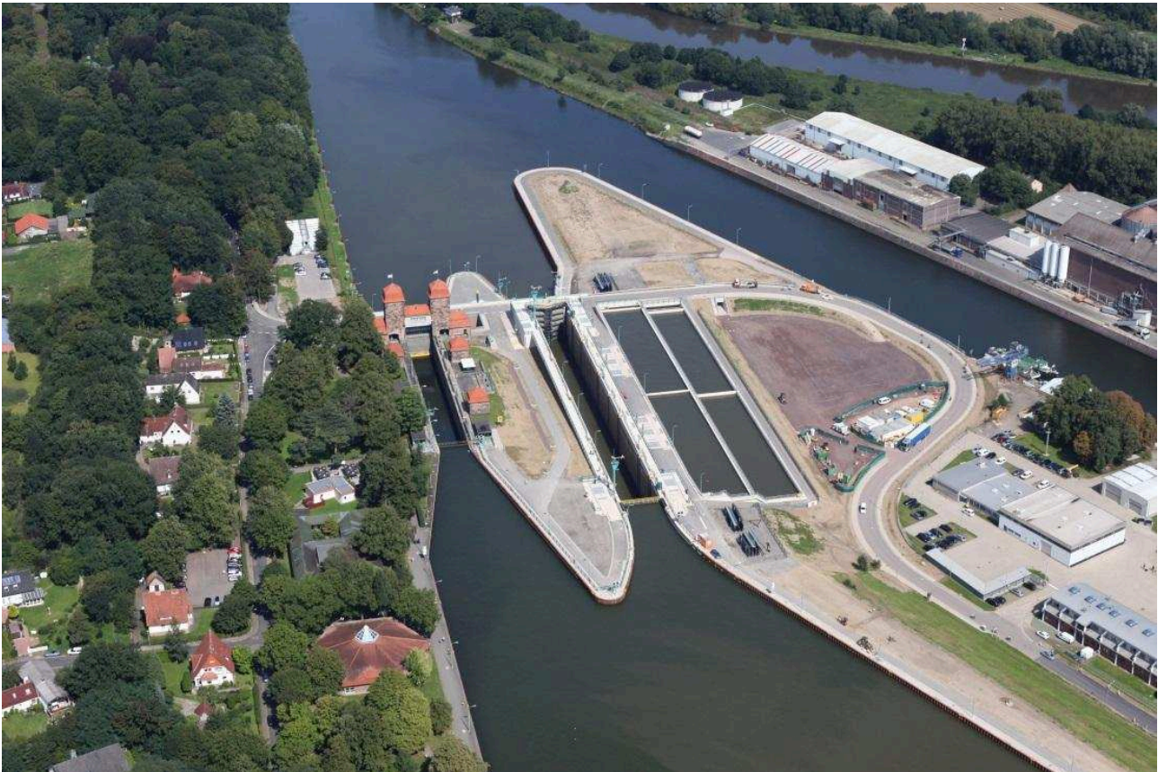
Bild 8: Luftbild der neuen Weserschleuse Minden.
