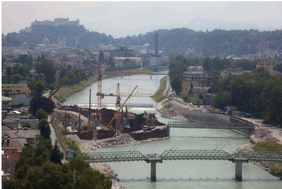
Bild 1: Errichtung Kraftwerk Sohlstufe Lehen Bauphase 1.
