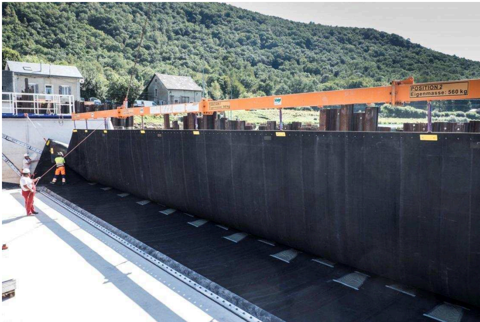
Bild 6: Montagephase 2- Membraneinbau.
