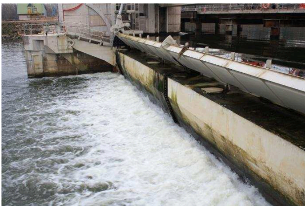
Bild 1: Unterströmtes Segmentschütz mit Aufsatzklappe. Links: Foto der Wehranlage, rechts: Ergebnis einer numerischen Simulation.
