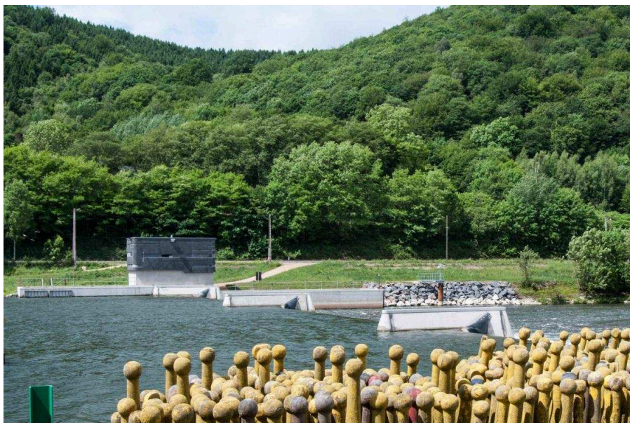
Bild 7: Schlauchwehr an der Meuse.
