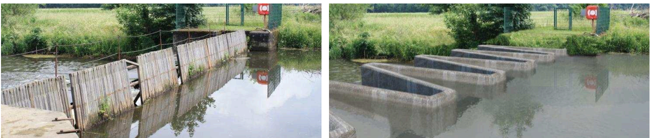
Bild 2: Nadelwehr (links) und Visualisierung eines möglichen Labyrinth-Wehres (rechts) am Standort Bardowick.
