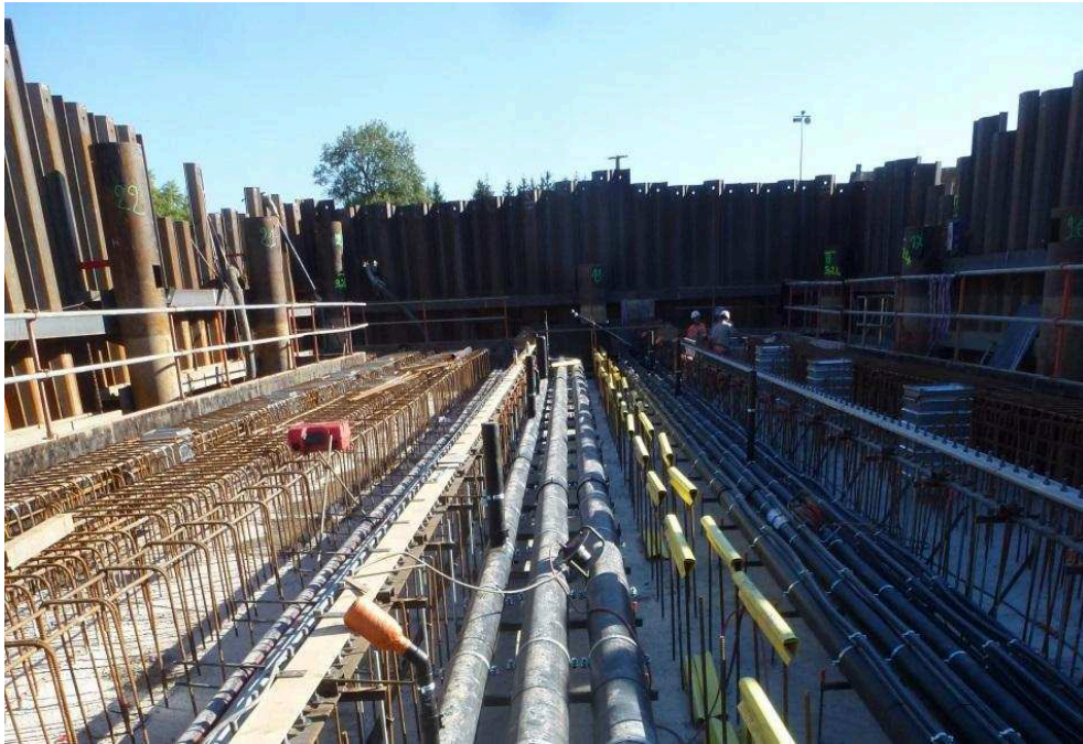
Bild 5: Montagephase 1 – Rohre und Unterschienen.
