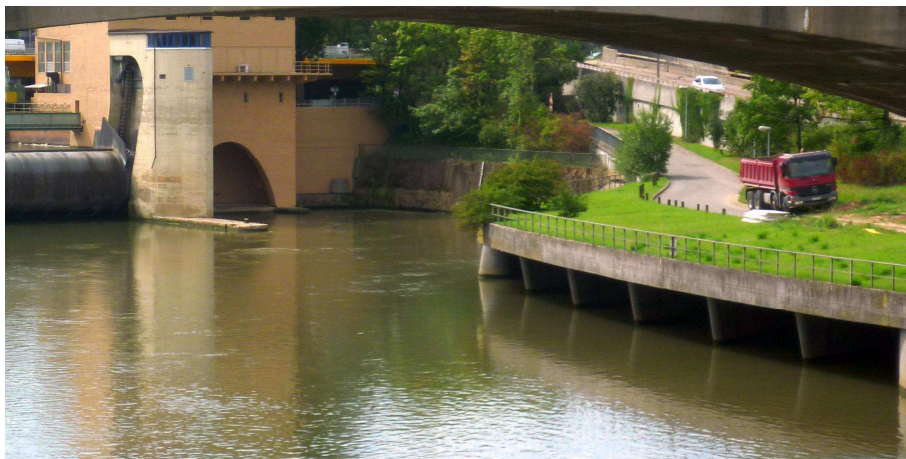
Bild 2: Einleitungsbauwerk des Hauptsammlers Nesenbach in Stuttgart am Neckar zur Mischwasserentlastung bei Starkregen (Belzner, BAW).
