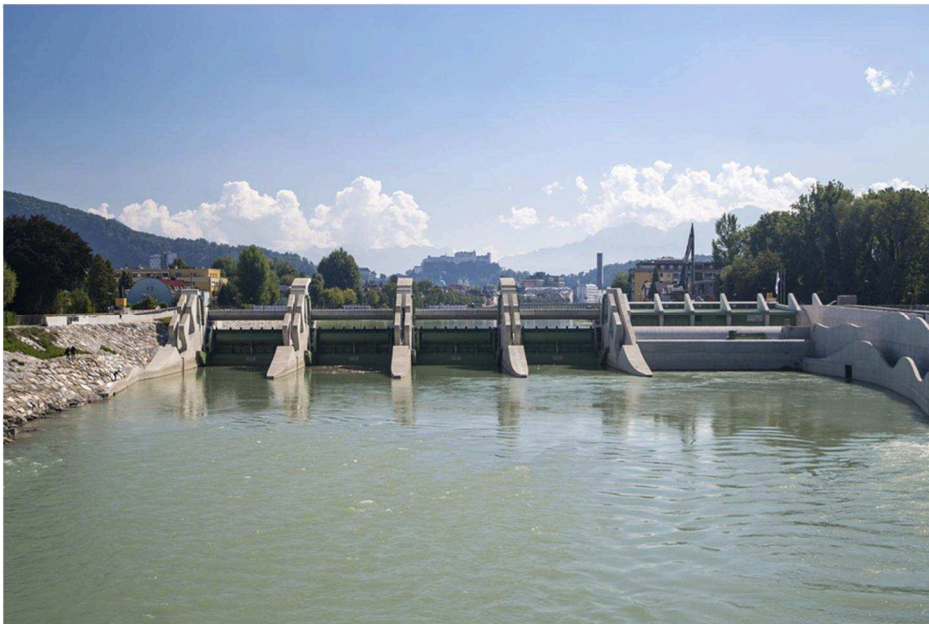
Bild 3: Kraftwerk Sohlstufe Lehen nach der Fertigstellung.
