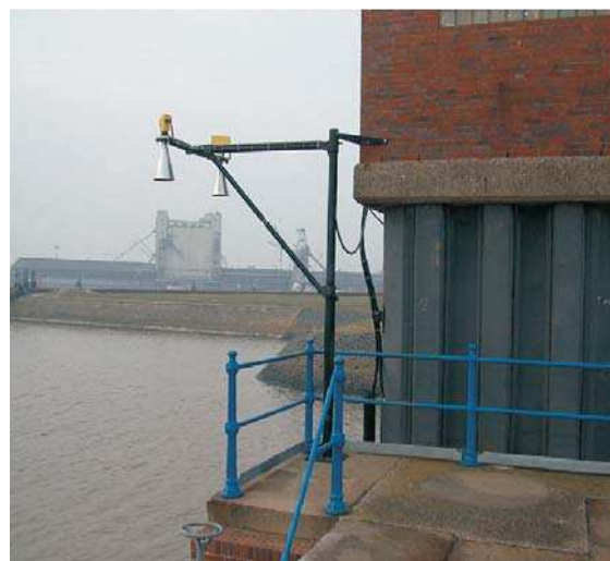
Abb. 2.18: Pegel Emden „Neue Seeschleuse“
