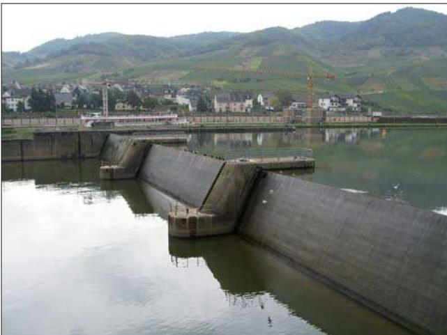
Bild 1: Staustufe Fankel mit einem dreifeldrigen Sektorwehr
