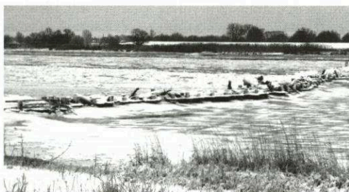
Abbildung 4: Buhne 6a bei Elbe-Km 450,75, rechtes Ufer, mit vereisten Buhnenfeldern und dem frei laufenden Strom vor der Streichlinie bei einer etwa dreißigprozentigen Eisbedeckung
