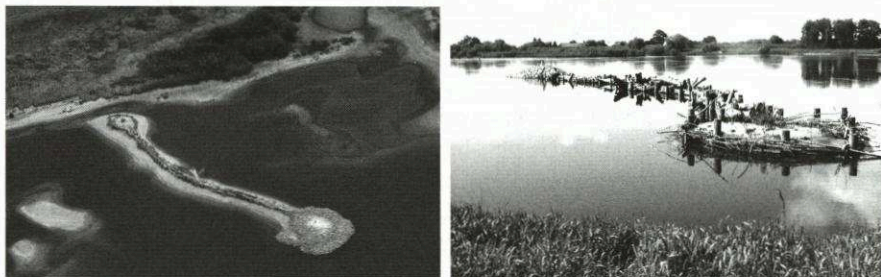
Abbildung 3: Buhne 6a bei Elbe-Km 450,75, rechtes Ufer ein Jahr nach Fertigstellung bei Niedrigwasser (linkes Bild) und Mittelwasser (rechtes Bild)
