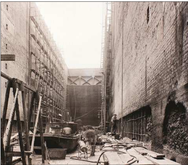
Bild 4: Betoninstandsetzung im Bereich der Kammerwände unmittelbar nach Fertigstellung
