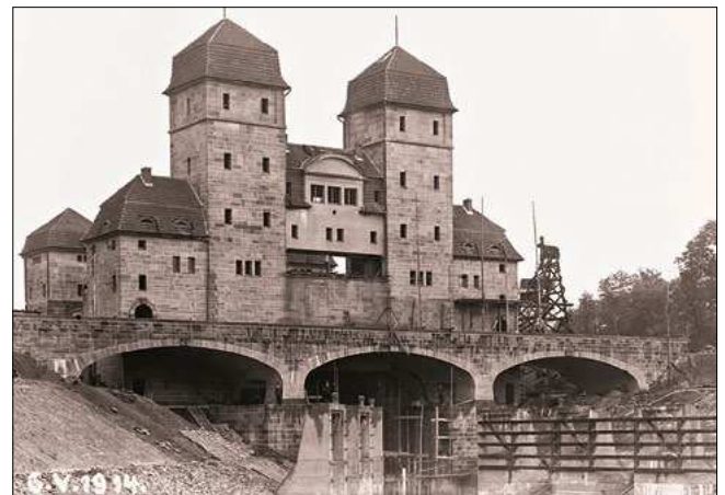
Bild 11: Ansicht der alten Schachtschleuse nach Fertigstellung mit Blick auf die Unterhauptbrücke
