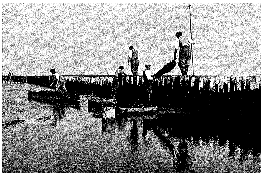
Abb. 3. Bau einer Buschlahnung Aufn. Odefey
