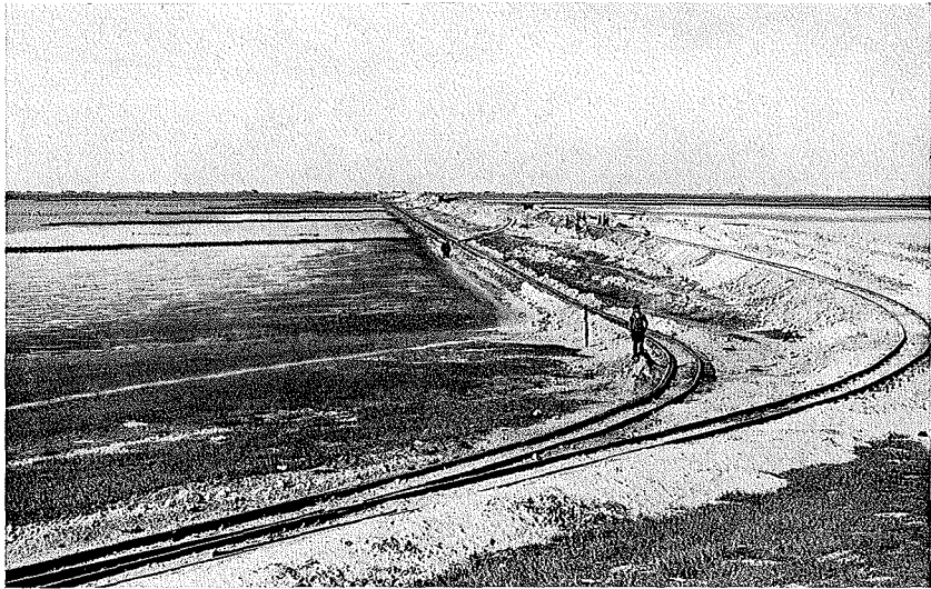
Abb. 20. Bodenschüttung beim Damm Festland Nordstrand Aufn. Hinrichsen
