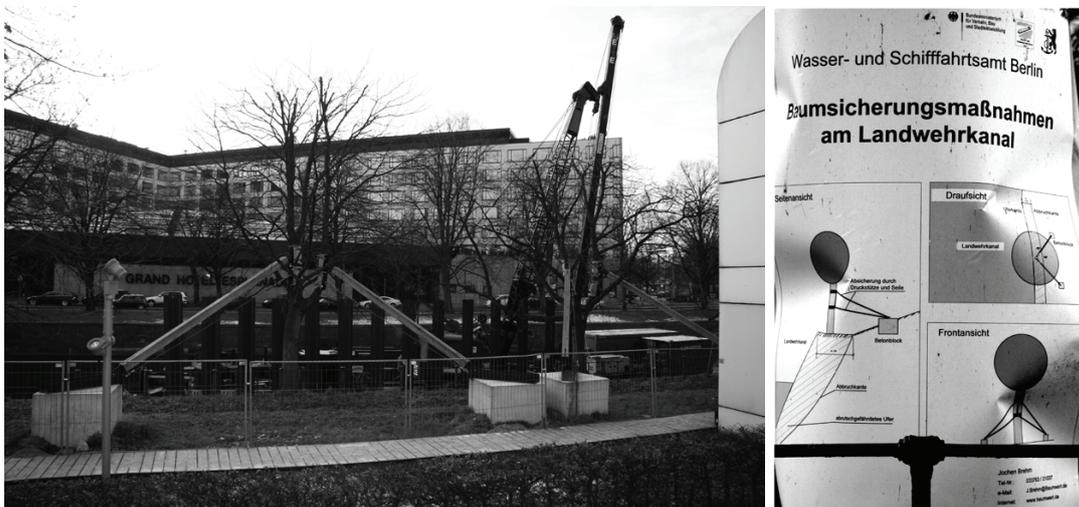
Bild 10: Baumsicherungen, Rammarbeiten am Landwehrkanal, Plakat
