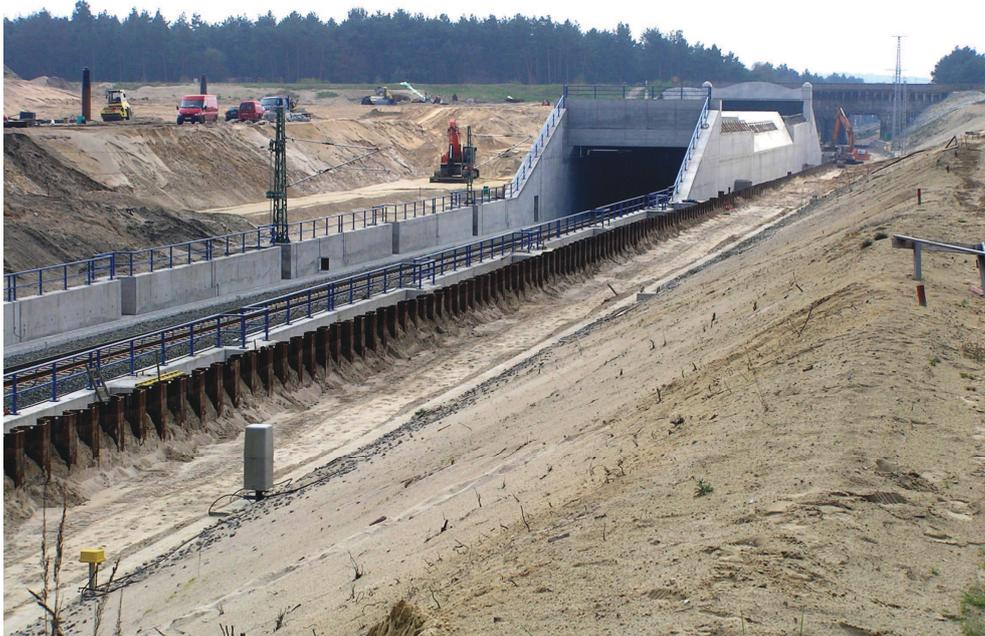
*Bild 2: Fertiggestellte Unterführung mit temporärer Spundwand*
