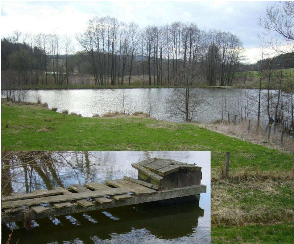
**Abbildung 1:** Kleine Talsperren: Stauteich als Teil einer Kaskade kleiner Becken in Osthü-
