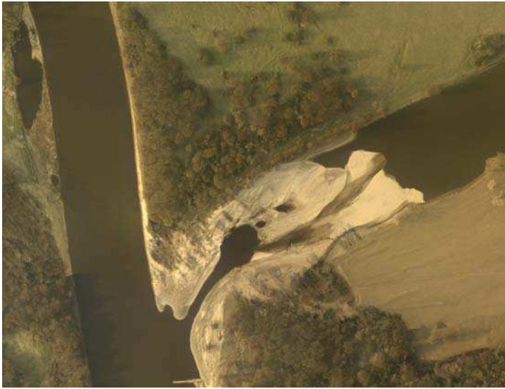
Abb. 1: Eintrag von Flusssedimenten in einen wieder angeschlossenen Altarm an der Elbe (Kurzer Wurf bei El-km 250)
