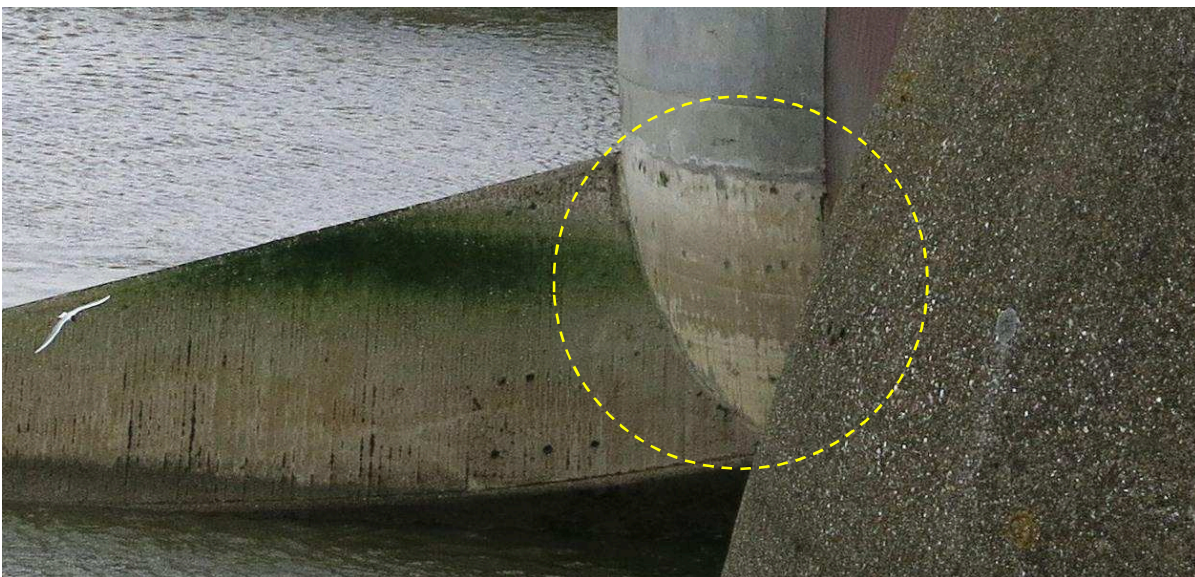
Bild 2: Reparaturfläche Eidersperwerk im Sommer 2014
