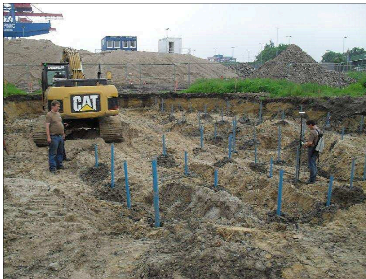
Bild 1: Kampfmittelsondierung für eine Baumaßnahme (Foto: KED, Hamburg)
