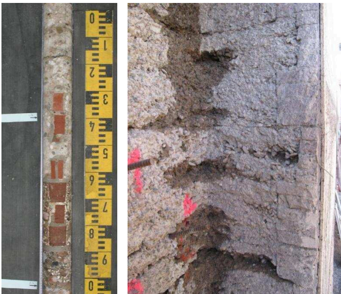
Bild 1: Injizierter Bohrkern (links), Verbund Vorsatzschale-Kernbeton (rechts)
