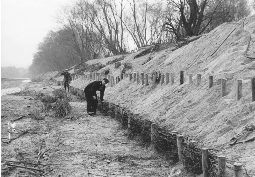
*Bild 1: Uferbefestigung am Altrhein bei km 433 (Foto: BAW, um 1960)*
