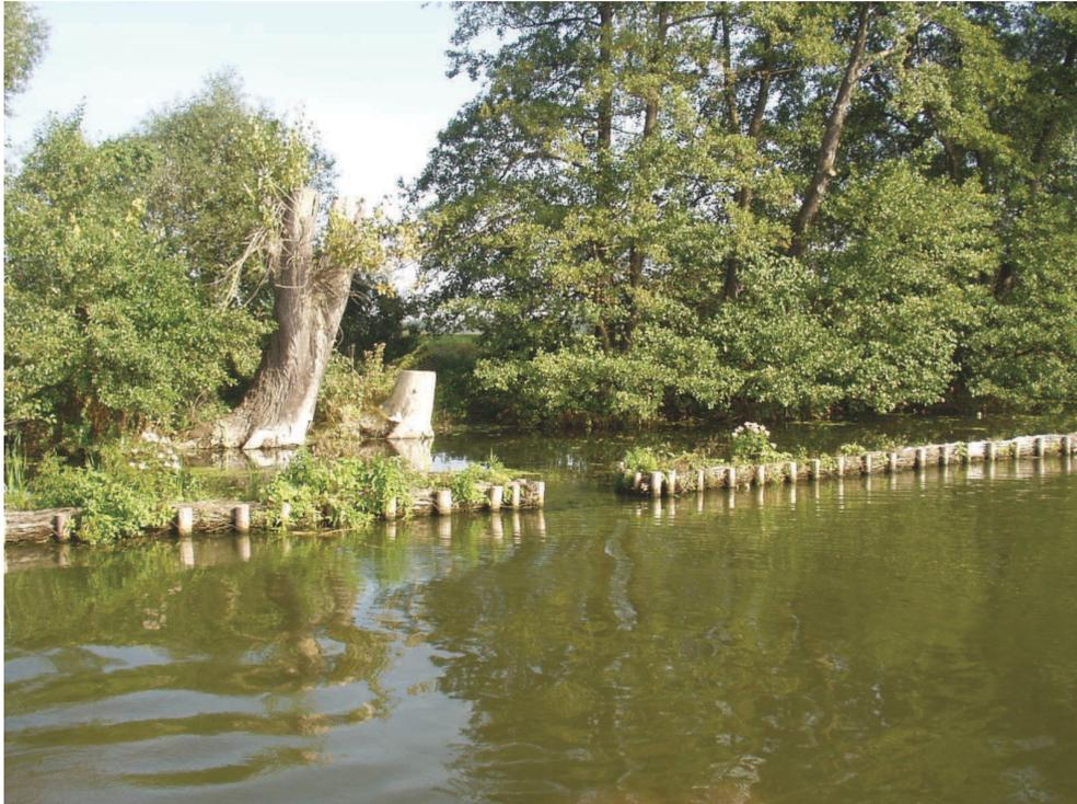
*Bild 2: Ufersicherung an der Unteren-Havel-Wasserstraße (Foto: Kai Schäfer, BMVBS)*
