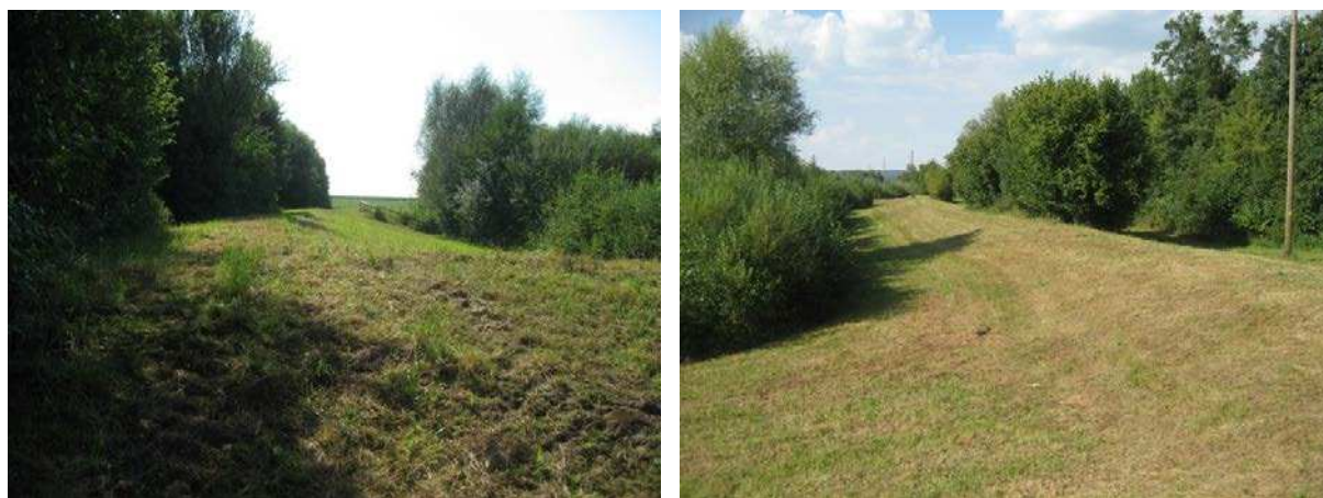
Abbildung 3: Hauptdamm (links), Östlicher Seitendamm (rechts)
