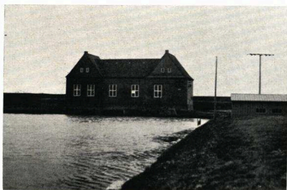
Abb. 10. Das in Bau und Leistung ( 23 \text{ m}^3/\text{s} ) 1951 verdoppelte Schöpfwerk Verlath Aufn. E. WOHLBERG, 1956
