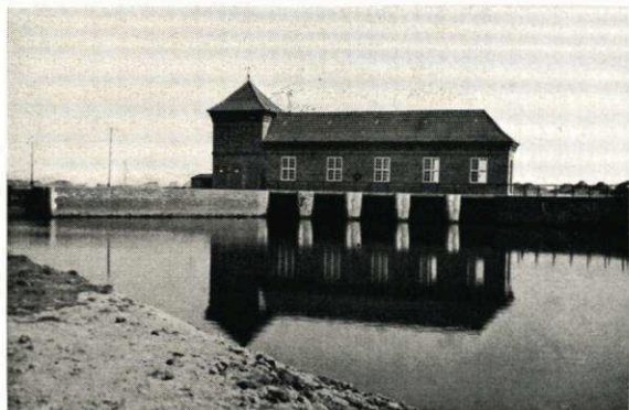
Abb. 8. Das erste Schöpfwerk für den Gotteskoog, Hemenswarf bei Südwesthörn. Baujahr 1928 Aufn. E. WOHLBERG, 1929
