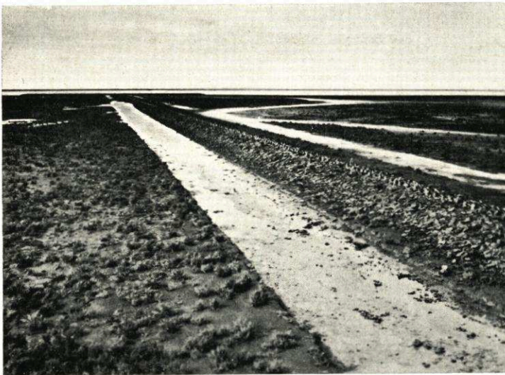
Abb. 41. Dasselbe Werk wie in Abb. 40 drei Jahre später. Durch die Gliederung der Wattoberfläche (Spatenarbeit) ist aus dem vegetationslosen Watt ein Salicornietum mit wasseruntersättigter Oberfläche geworden Bildarchiv Marschenbauamt Husum. Aufn. ODEFEY, 1930
