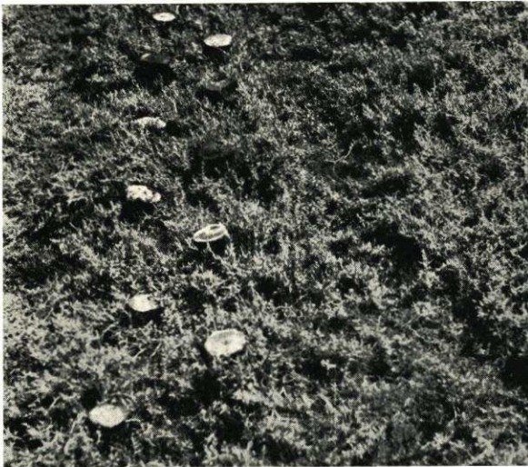
Abb. 46 Die bei ihrer Errichtung das Watt um 1,00 m überragende Lahnung ist vollkommen verlandet und liegt unter den jungen Ablagerungen begraben
