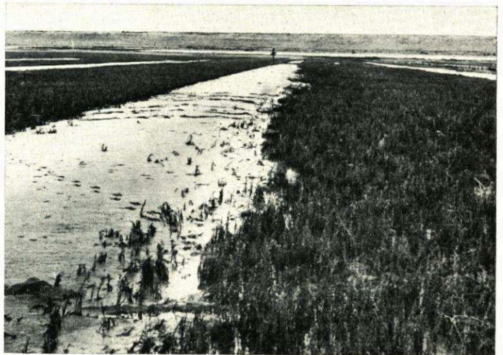
Abb. 50 Überfüllte Grütpe. Im Hintergrund der Damm. Die Grüttenoberfläche liegt höher als der Acker, also Profilmkehr (vgl. schemat. Abb. 57, C)
