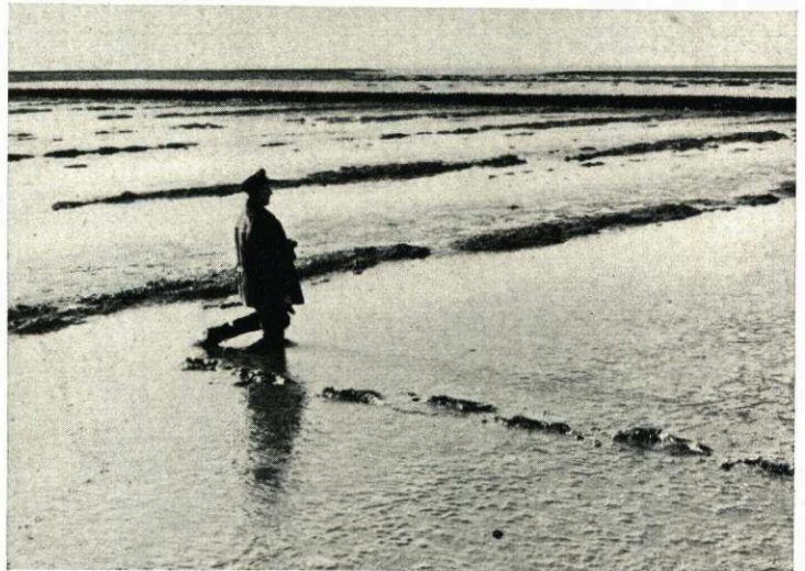
Abb. 36 Nach dem erstmaligen Aus- hub der Gruppen geht die Sedimentation neuer Sink- stoffe pausenlos weiter. Hier sollte der Gruppen- aushub mehrere Male im Jahr vorgenommen werden
