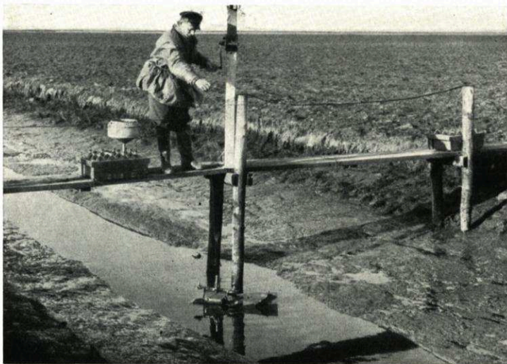
Abb. 9. Sinkstoffentnahme in einer Hauptentwässerung südlich vom Hindenburgdamm Bildarchiv Westküste, Januar 1954. Aufn. E. WOHLBERG
