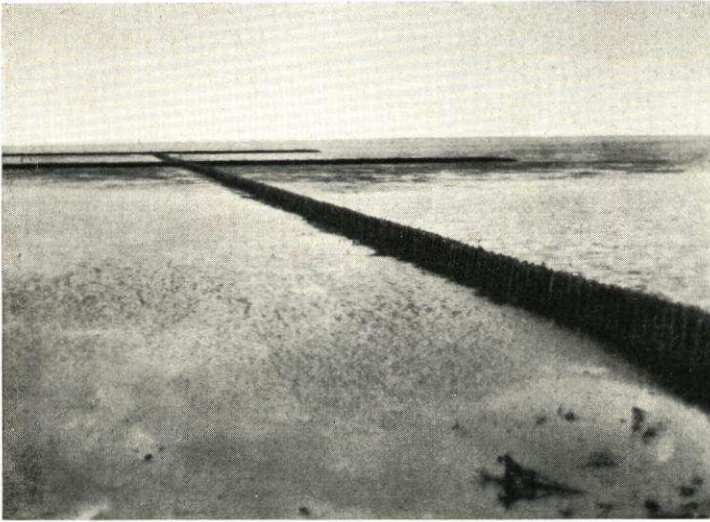
Abb. 40. Erste Lahnung bei Benninghusum, 5 km südlich vom Damm. Die Wattoberfläche ist noch im Naturzustand, wasserübersättigt Bildarchiv Marschenbauamt Husum. Aufn. ODEFEY, 1927
