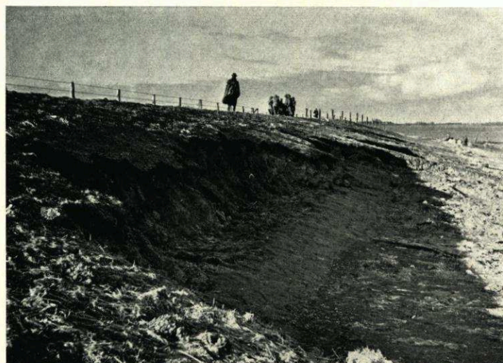
Abb. 8. Schwerer Schaden in der Außenböschung Aufn. Wasserwirtschaftsamt Aurich
