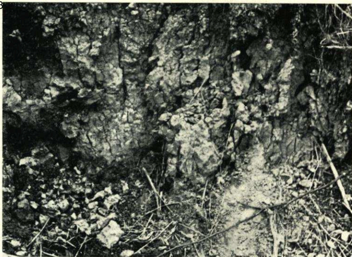
Abb. 18. Rissige und krümelige Struktur des Bodens im Kern eines alten Deiches an einer Bruchstelle
