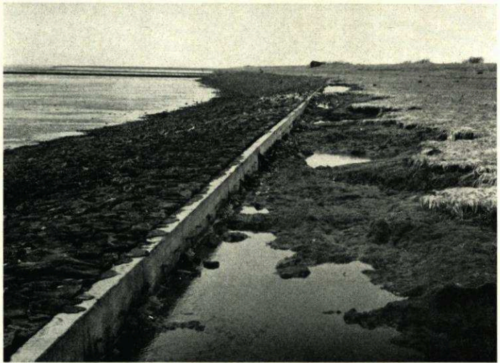
Abb. 13. Zerstörte Außenberme am Deckwerk des Hauptdeiches an der Jade nördlich Eckwarderhörne
