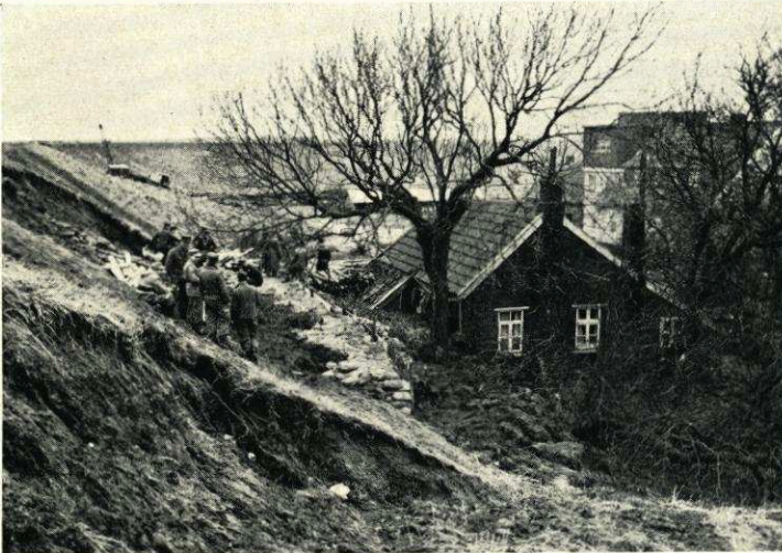
Abb. 27. Durch Rutschung der Binnenböschung verschüttetes Haus bei Pogum an der Ems
