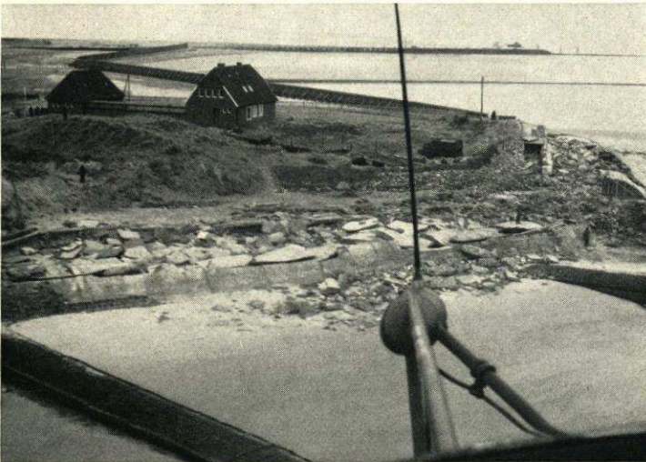
Abb. 35. Zerstörte Strandmauer am Westende von Baltrum
