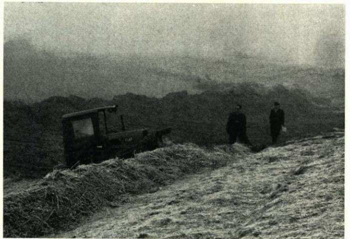
Abb. 16. Räumen der ungewöhnlich großen Treibselmenge mit Hilfe einer Planierraupe am östlichen Weserdeich bei Aschwarden
