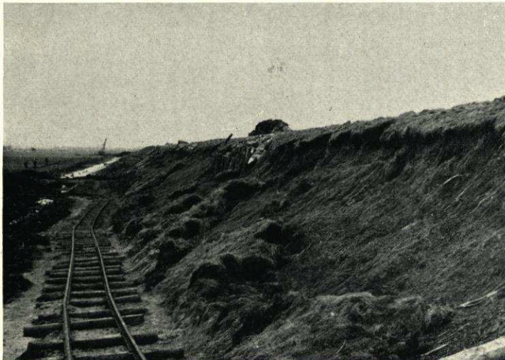
Abb. 28. Rutschungen an der Binnenböschung des Hauptdeiches vor dem Augustgroden an der Ostseite des Jadebusen
