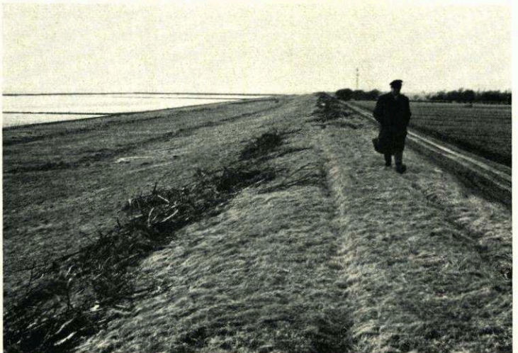
Abb. 11. Verschieden hohe Treibselgrenze am Deich infolge unterschiedlicher Höhe der Außenberme am Deich an der Jade nördlich Eckwarderhörne
