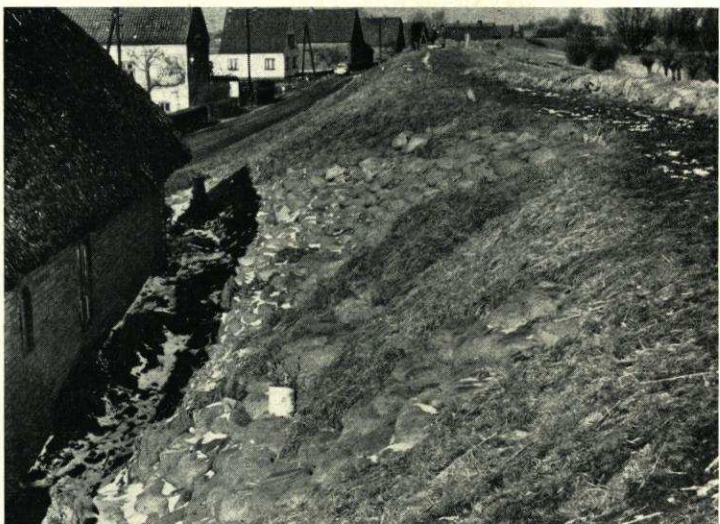
Abb. 19. Starke Schäden an der steilen Binnenböschung bei einem im Deichprofil stehenden Haus
