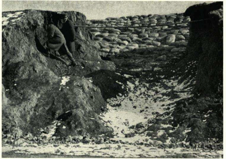
Abb. 29. Deichbruch bei Piependamm an der Unterweser, durch Sandsackwall abgesichert; der gute Deichboden an den steilen Wänden der Durchbruchstelle erkennbar
