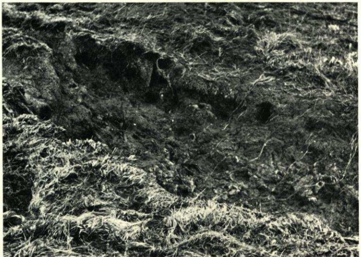
Abb. 14. Ausschlag in der Deichböschung mit freigelegten Wühlgängen
