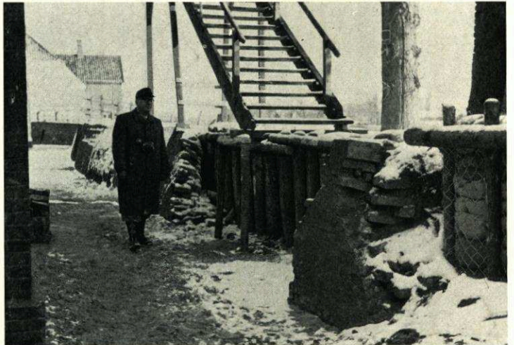
Abb. 32. Zerstörte baufällige Stützmauer aus Ziegelsteinen in Oberndorf an der Oste
