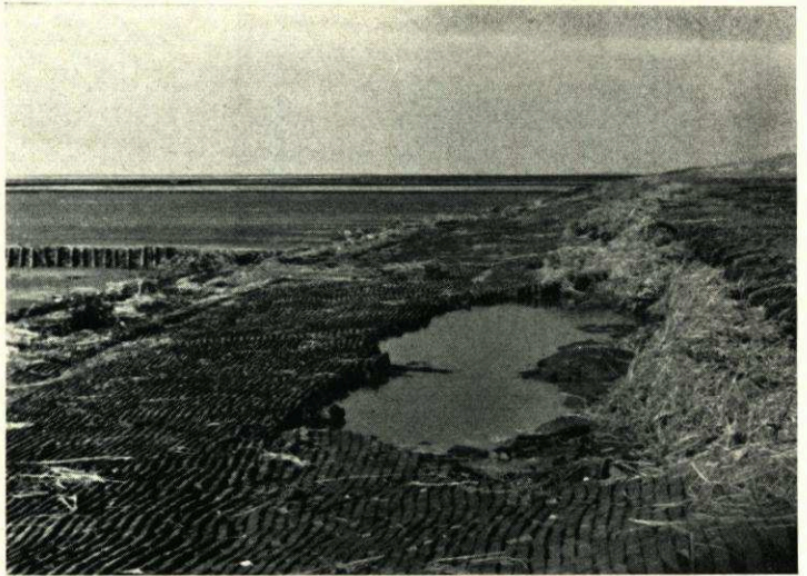
Abb. 12. Stark beschädigte Ziegelsteinbank vor dem Hauptdeich an der Außenems
