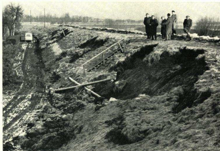
Abb. 24. Deichlängsweg durch Abrutschung der Binnenböschung verschüttet, z. Z. der Aufnahme bereits wieder geräumt
