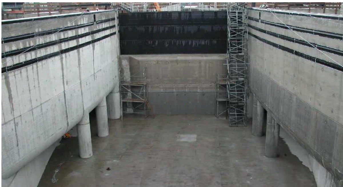
Abbildung 1: Schleuse Sülzfeld, Blick vom Oberwasser auf den fertig gestellten Einlauf mit seitlicher Wasserentnahme hinter den Säulen (Neubauamt Hannover, 2007)
