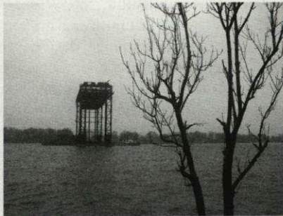
Abbildung 1 Übergang Peenestrom / Stettiner Haff bei Karnin (Karniner Brücke)
