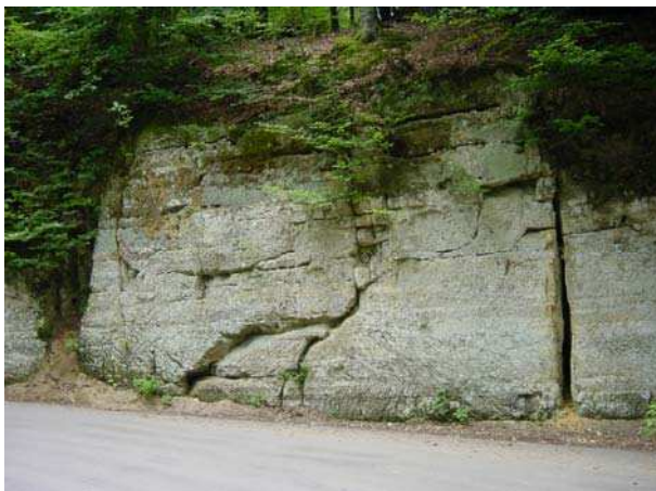
Bild 1: Sandsteinbank mit Vertikalklüften, horizontalen Schichtfugen und diagonalen Entlastungsklüften
