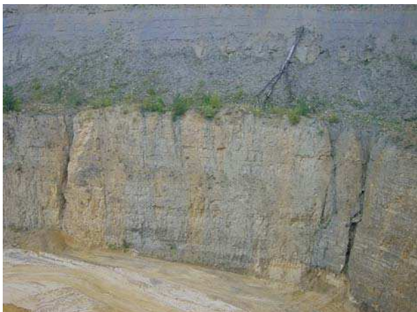
Bild 5: Stockwerksbau im Festgestein: weitständige Klüftung im Sandstein mit Mergelsteinüberdeckung, in die sich die Vertikalklüfte aus dem Liegenden nicht fortsetzen
