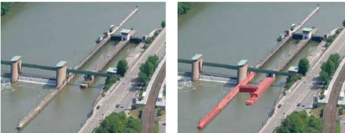
Simulierte Verlängerung der rechten Kammer der Schleuse Neckargemünd nach Unterwasser (Auszug aus dem Kompendium der WSD Südwest, Juni 2007)
