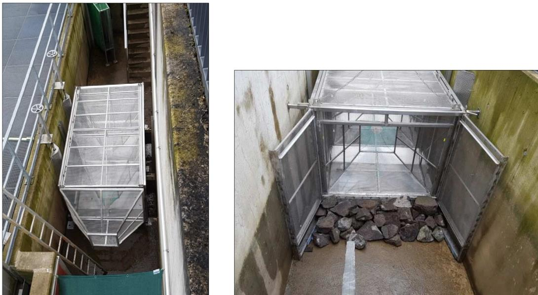
**Abb. 3:** Einbau des Prototyps der Standardreuse in einem speziellen Zählbecken einer FAA zur Bestimmung der Fängigkeit (Fotos: BfG)
