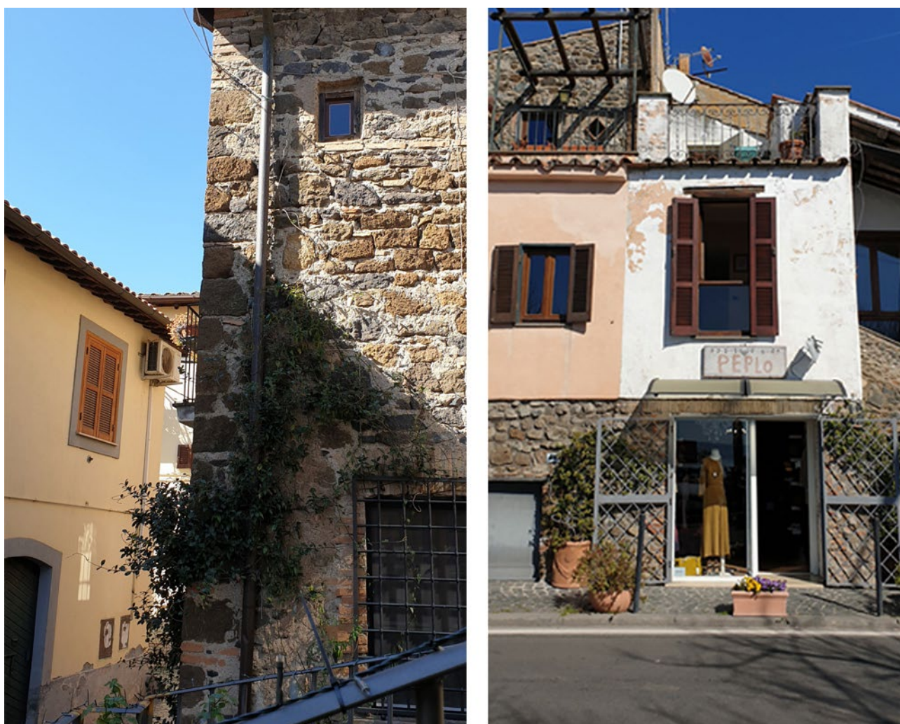
Figura 5: Centro storico, infissi in legno. Fonte: foto degli autori.
