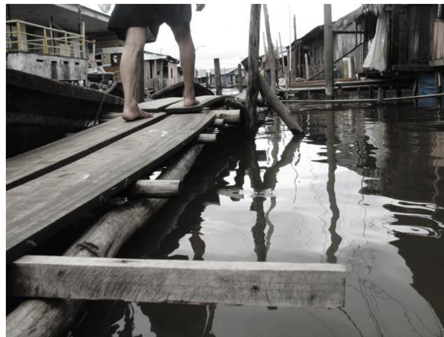
Estructura de puente
