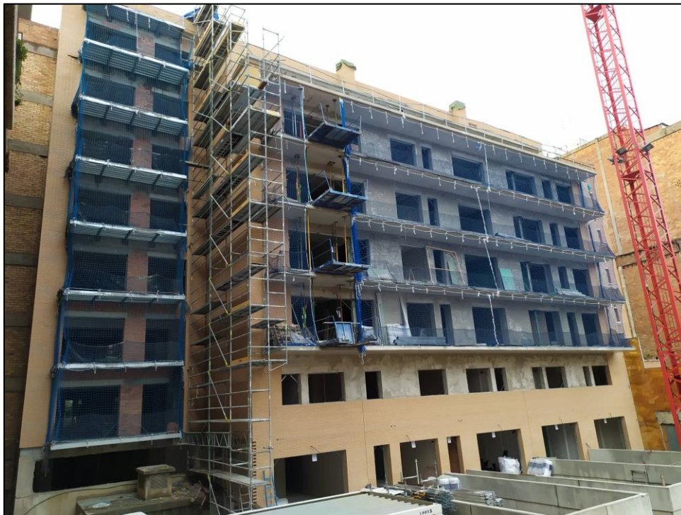
Fig. 17: Fotografía en obra del Proyecto 1, ángulo 2.
