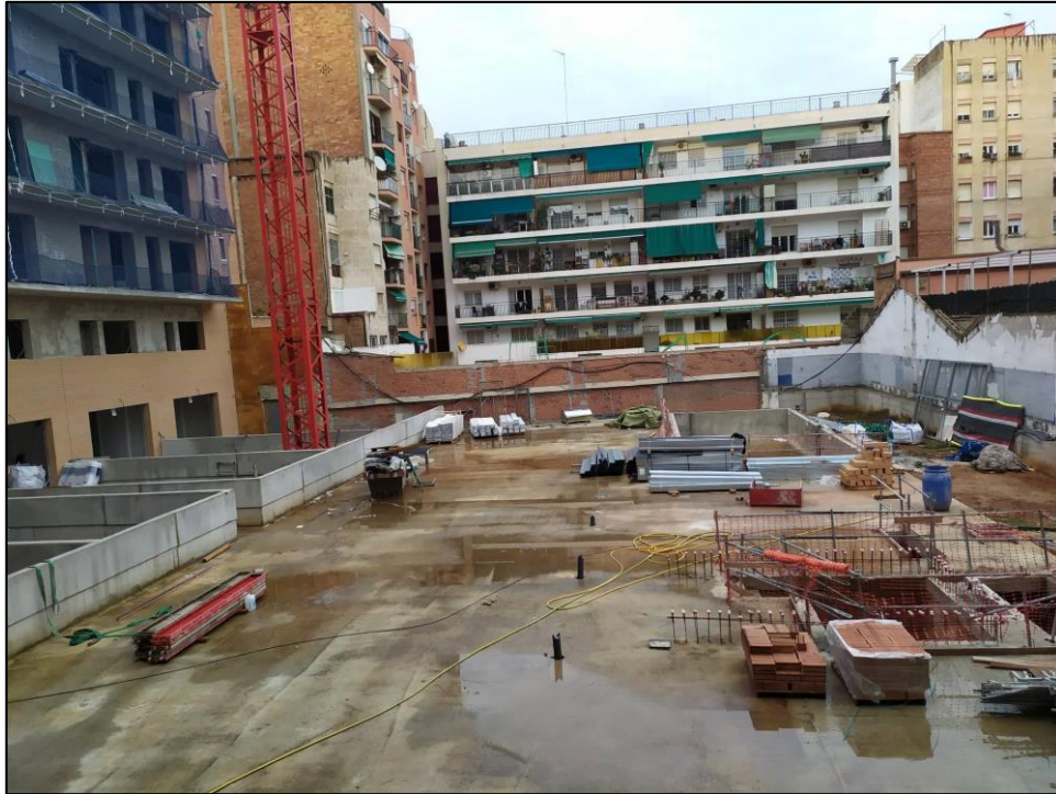
Fig. 16: Fotografía en obra del Proyecto 1, ángulo 1.
