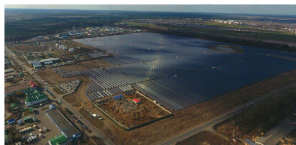
Рис. 4. Фотоэлектростанция в Речицком районе
