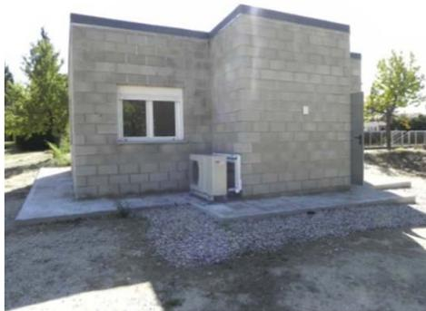
Figura 4. Bomba de calor reversible aire-agua.
