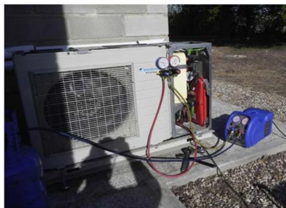
Figura 22. Método para determinar el refrigerante fugado.
