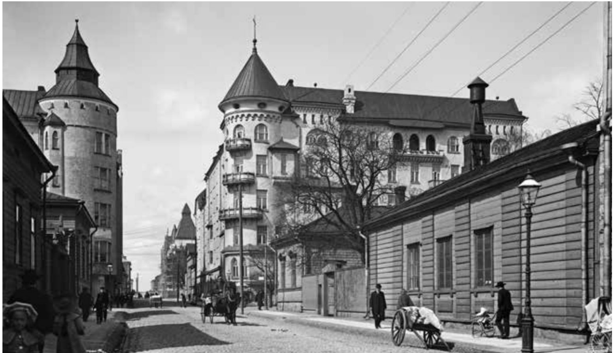
Kuva 35: Näkymässä Fredrikinkadulta Bulevardin ja Fredrikinkadun risteykseen näkyy vuosisadanvaihteen muutos rakentamisessa. Bulevardin pohjoispuolta hallitsevat linnamaiset jugendtalot kun etelälaidalla on vielä yksikerroksisia puutaloja. Signe Brander, 1907, Helsingin kaupunginmuseon kuva-arkisto.
